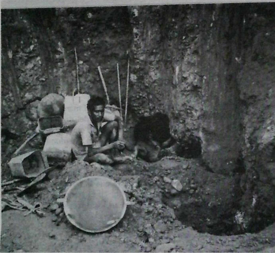
Ensanche de un apique en Ataco-Tolima.
