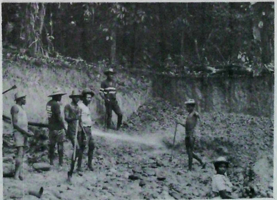
Explotación por Motobomba y Monitor. Minas Gertrudis-Barbacoas
