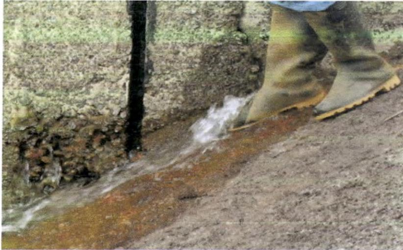
FOTOGRAFÍA No. 3. Sitio del muro de contención donde se presenta una de las filtraciones
