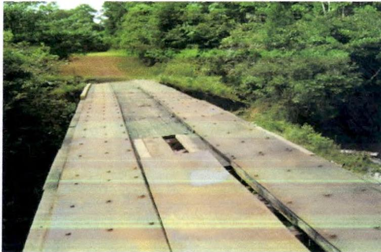
FOTOGRAFÍA No. 1. Avance de colocación de las láminas de Alfajor sobre el tablero del Puente del Caño Cucura
