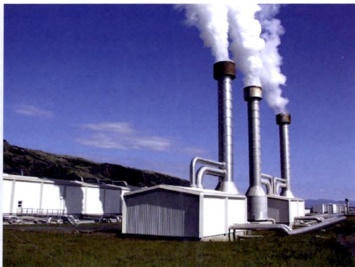
Figura 1.8 Chimeneas de emisión de gases, en una planta geotérmica
