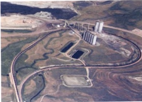
Foto. Almacenamiento (silos), cargue y transporte (férreo) del mineral. Cortesía de CARBOCOL.
