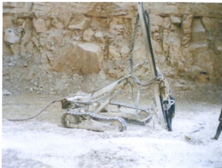
Foto. Perforación mediante join minero para barrenos de hasta 6 m en minería a cielo abierto (cortesía David Buitrago Salomón).
