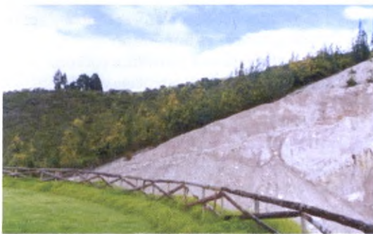
Foto: Recuperación paisajista de talud sobre su cresta (Cortesía Adolfo Correa)
