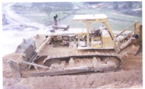
Foto. Bulldozer con ripper para efectuar preparación de frentes de explotación. (Cortesía David Buitrago Salomón)
