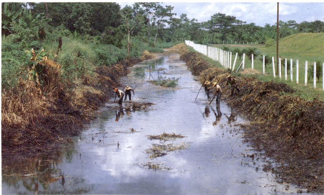
Distrito de Producción El Centro Trabajos de recuperación de áreas afectadas por derrames
