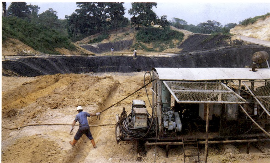
Construcción de obras permanentes para controlar incidentes de contaminación con hidrocarburos
