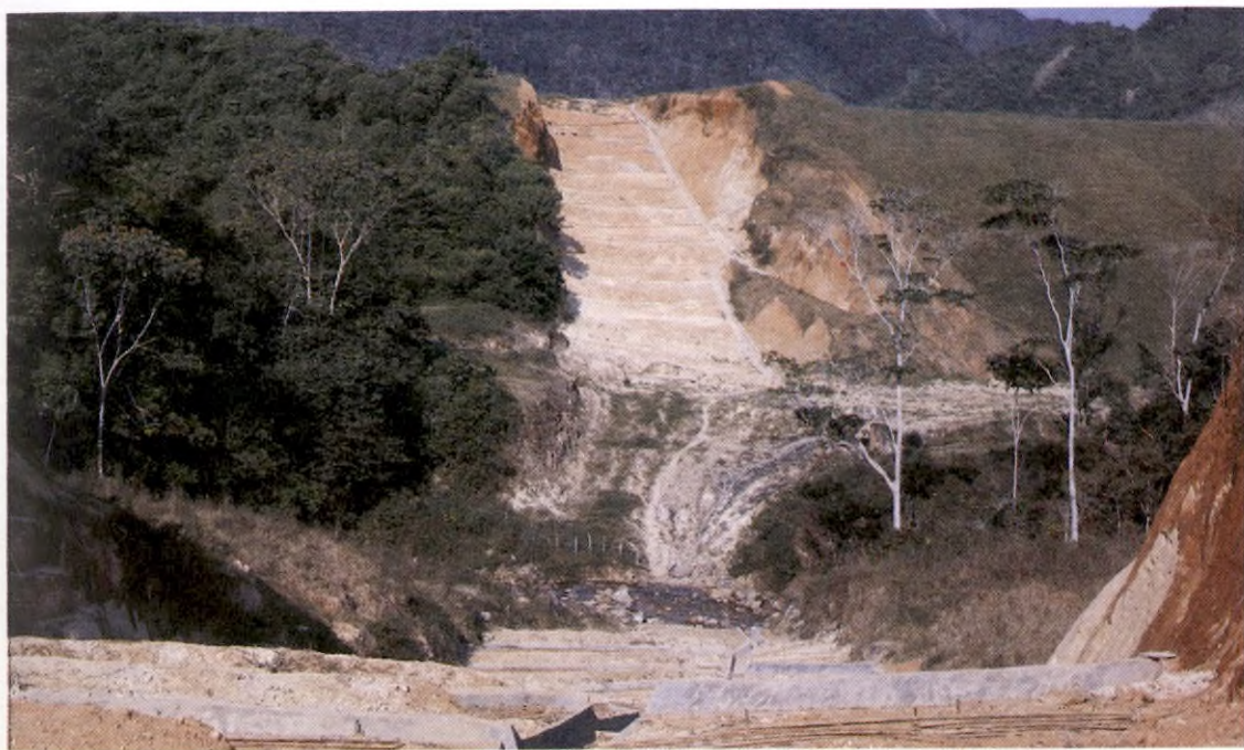
Distrito Caño Limón- Coveñas Obras de estabilización del derecho de vía del oleoducto
