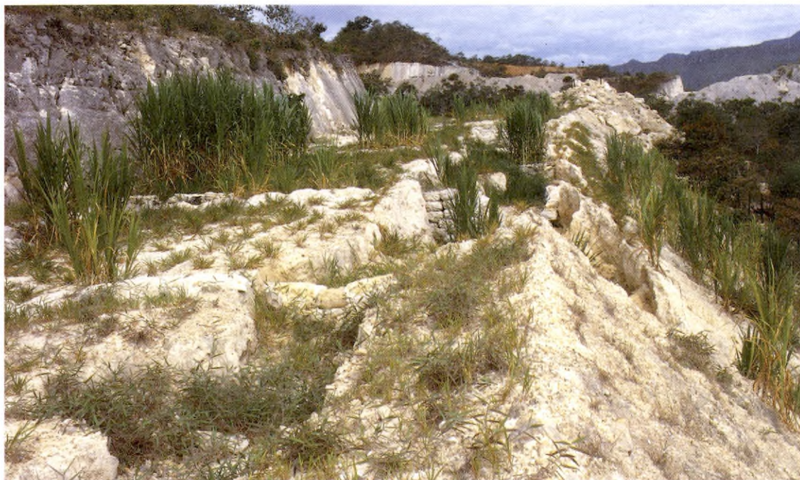
Distrito de Oleoductos Control de erosión mediante la revegetalización del derecho de vía en la construcción de oleoductos
