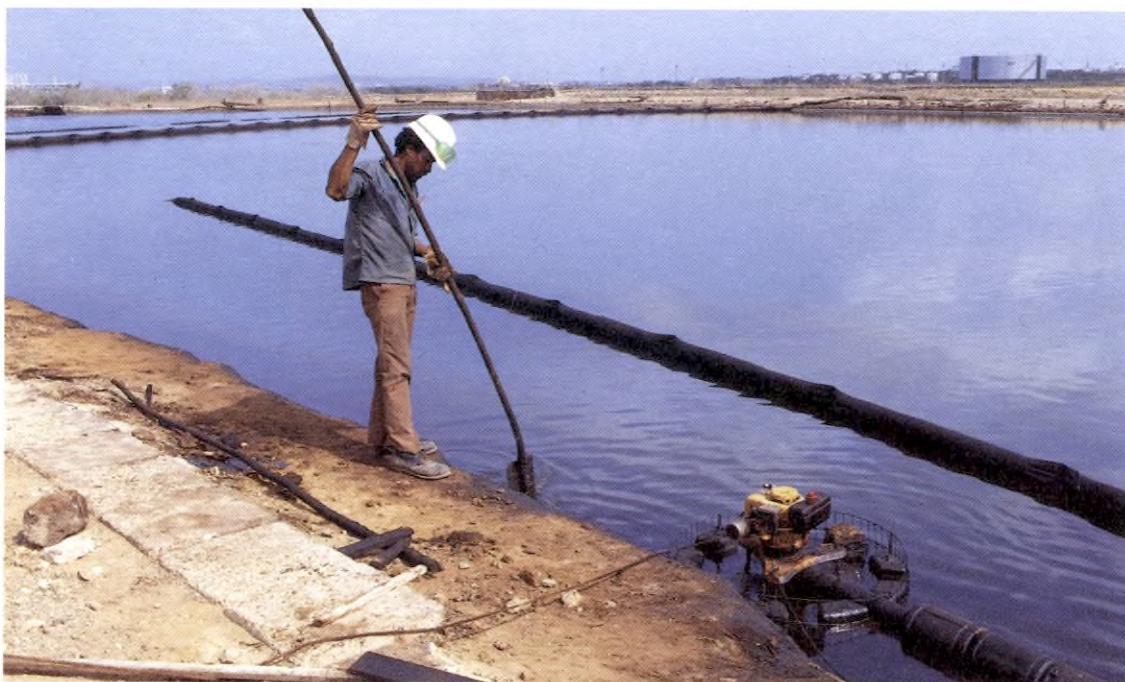
Distrito de Cartagena Laguna de tratamiento de aguas residuales
