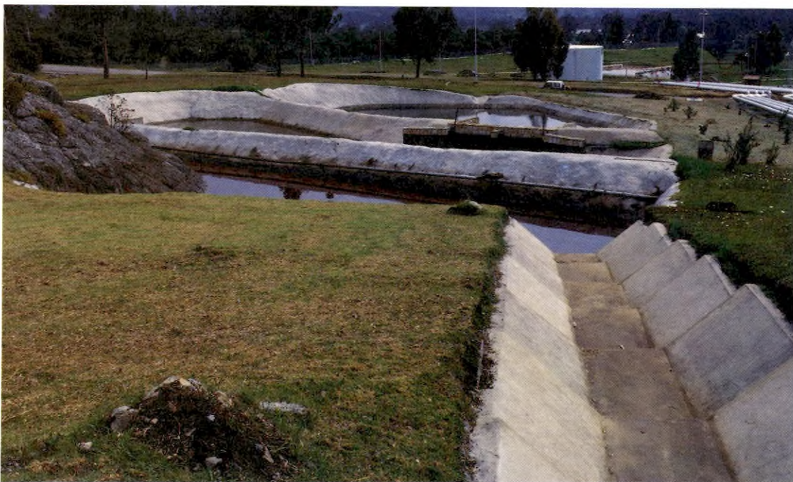
Distrito de Oleoductos Terminal de la Sabana (Facatativá) Lagunas pre-separadoras de aguas aceitosas
