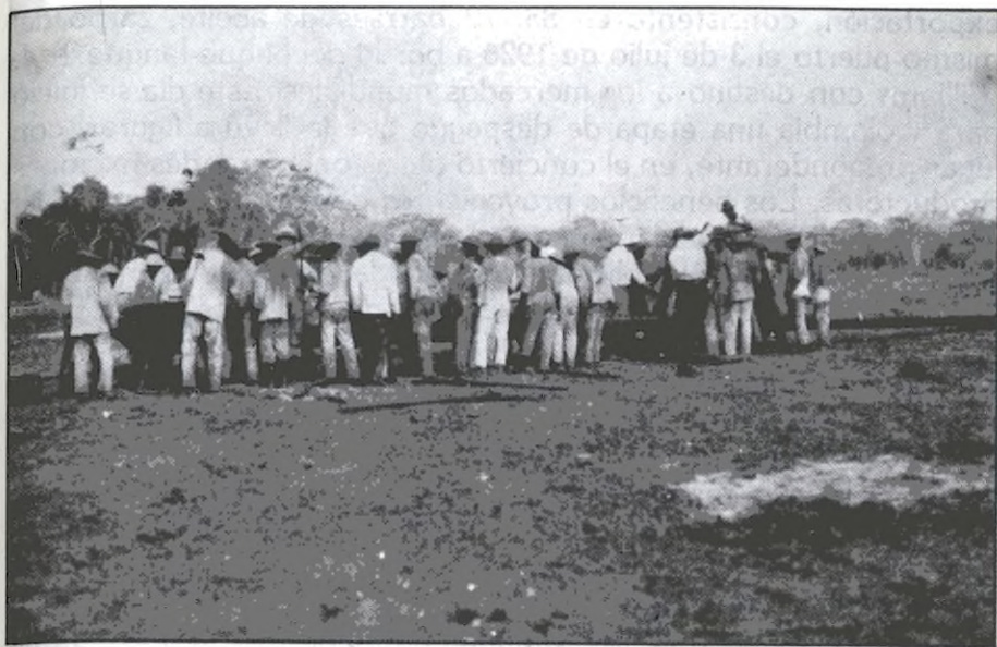
Trabajos de construcción del Oleoducto.
