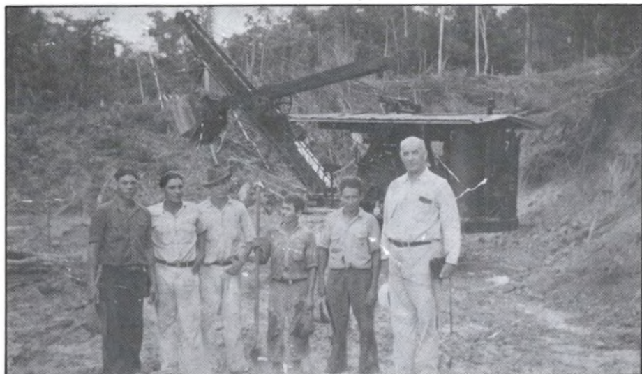
Pala N° 7 de gasolina y aire durante las obras de explanación para pozos en el sector del campo 5. Aparece el jefe de ingeniería, Mr. Smith (1940).
