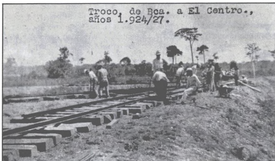
Construcción del ferrocarril entre Barrancabermeja y El Centro (1924).
