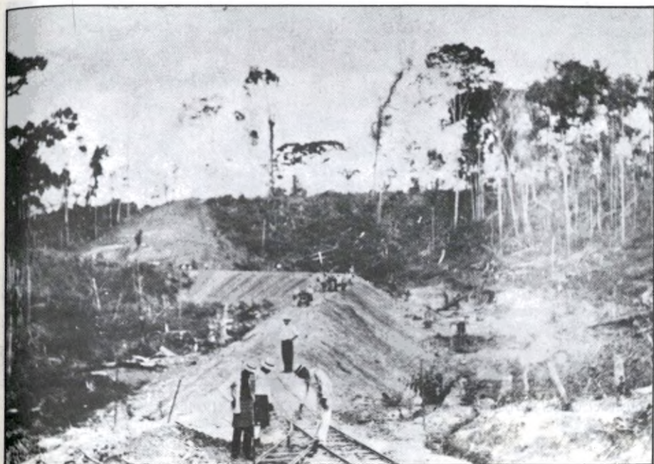
Construcción del ferrocarril entre Barrancabermeja y El Centro (1924).
