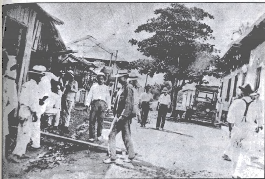
Calle de la Campana (1927).
