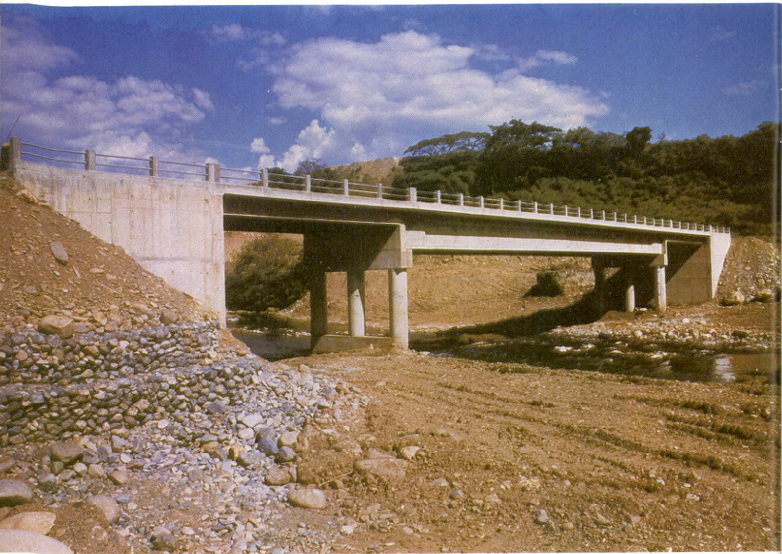
Puente de Venecia Reposición vía Yaguará - Hobo (Ley 56 de 1981)
