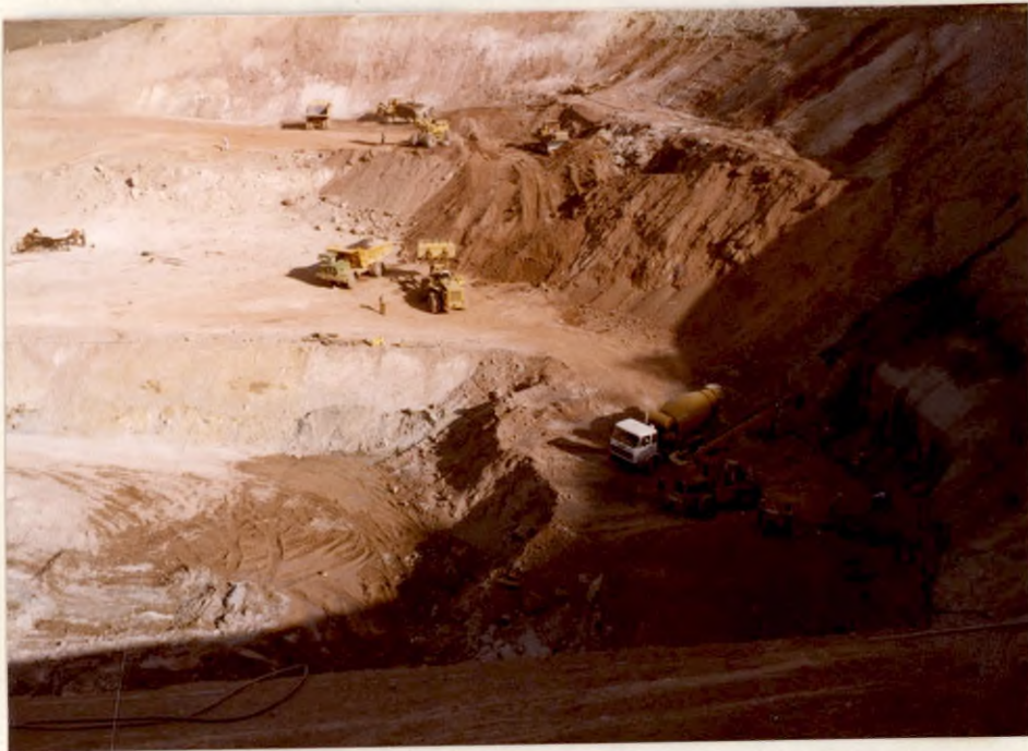
Aspecto general del avance de la excavación de los portales. En primer plano el portal No. 2.
