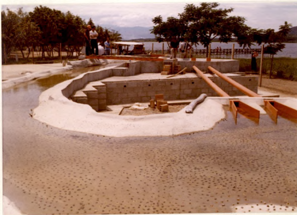
Detalle de la zona de salida de los túneles de desviación.
