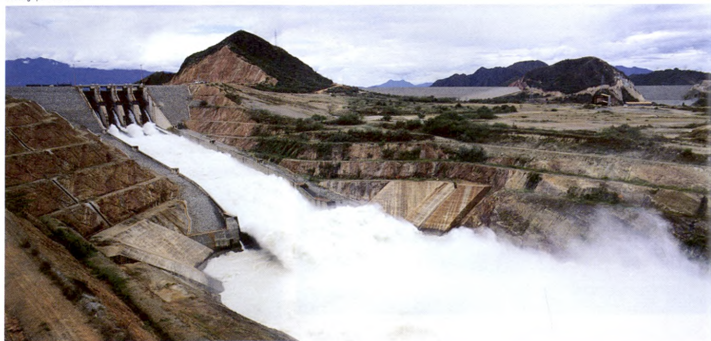
Descarga por Vertederos
