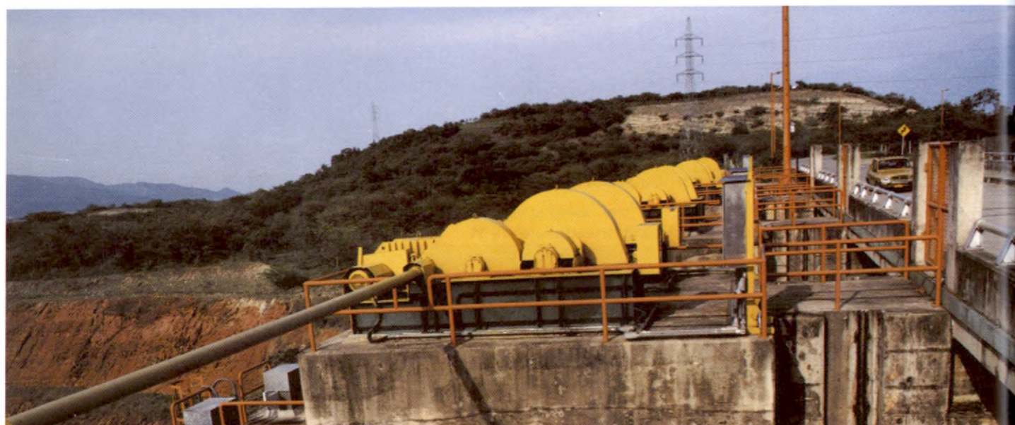
Vertedero de Compuertas
