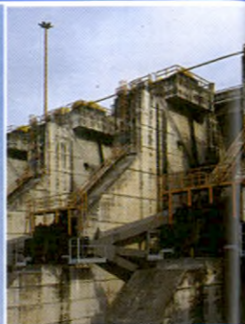
Compuertas del Vertedero
