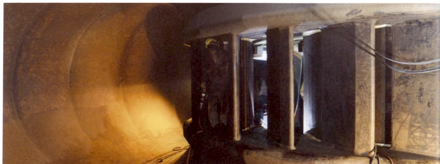
Mantenimiento al Distribuidor de Turbina
