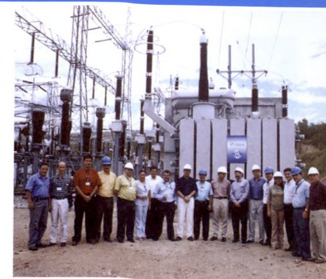
Inauguración Nuevo Banco de Transformación
