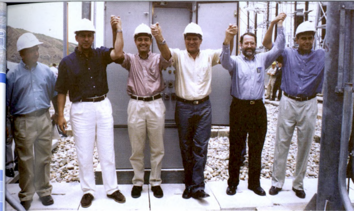
Inauguración Nuevo Banco de Transformación
