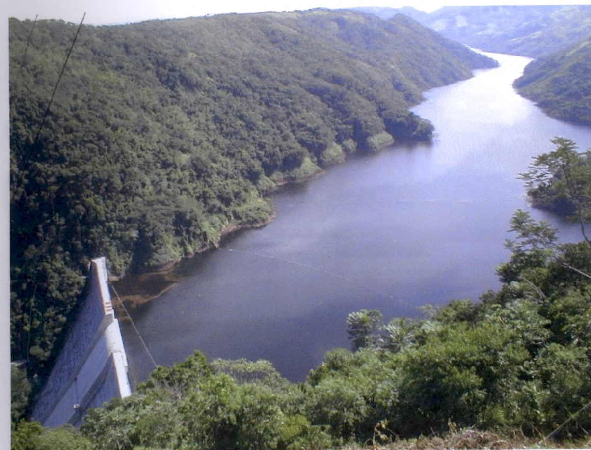
FOTOGRAFÍA 6 PRESA Y ZONA DE EMBALSE DE LA CENTRAL HIDROELÉCTRICA MIEL I.
