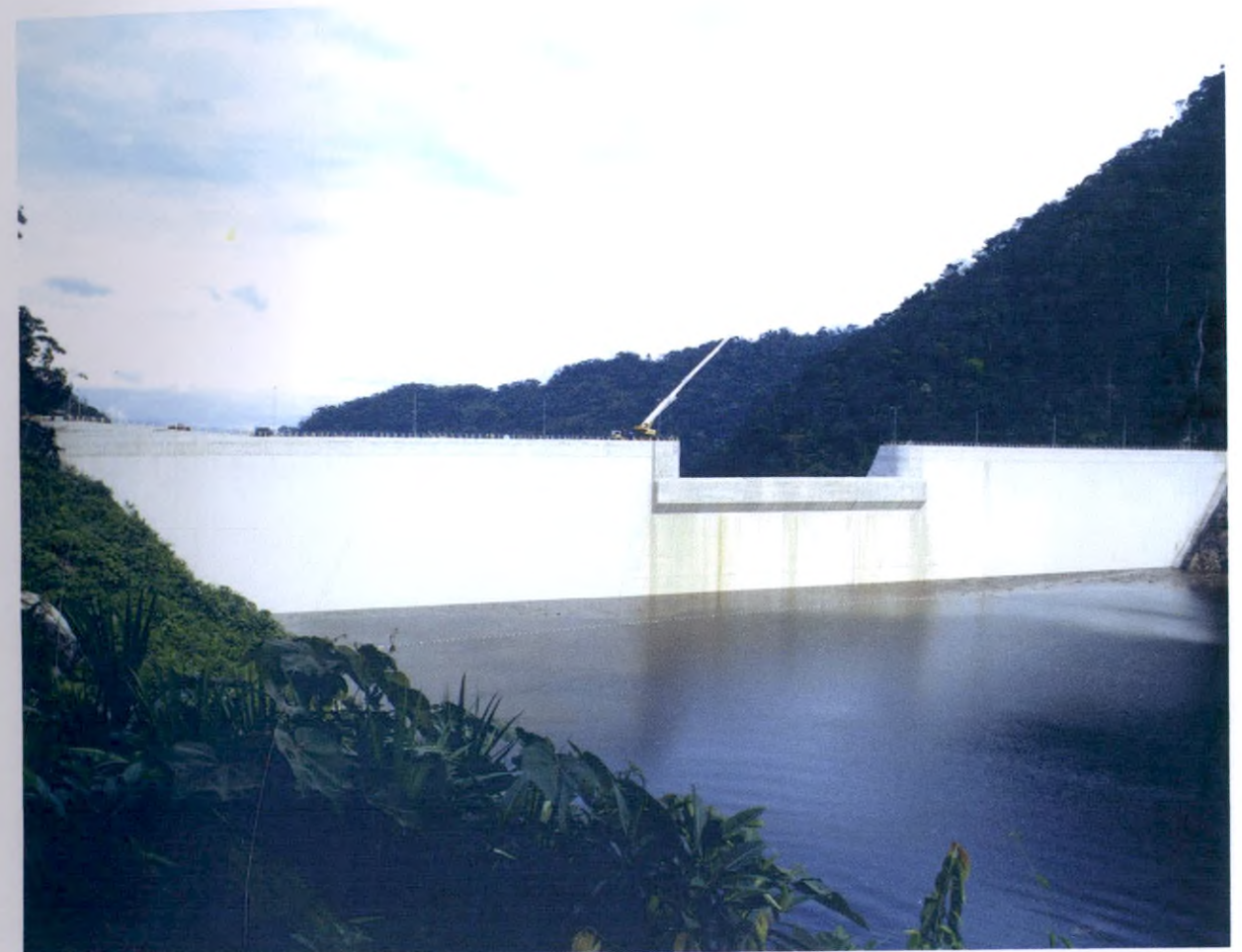
FOTOGRAFÍA 7 PRESA – VISTA CARA AGUAS ARRIBA
