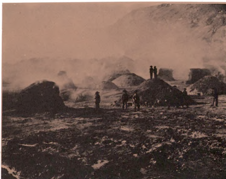
EXPLANADA DE LAS CALCINACIONES, MAS CONOCIDOS POR «TELERAS», PROCESO METALURGICO EN DESUSO, FOTO 1.888.
