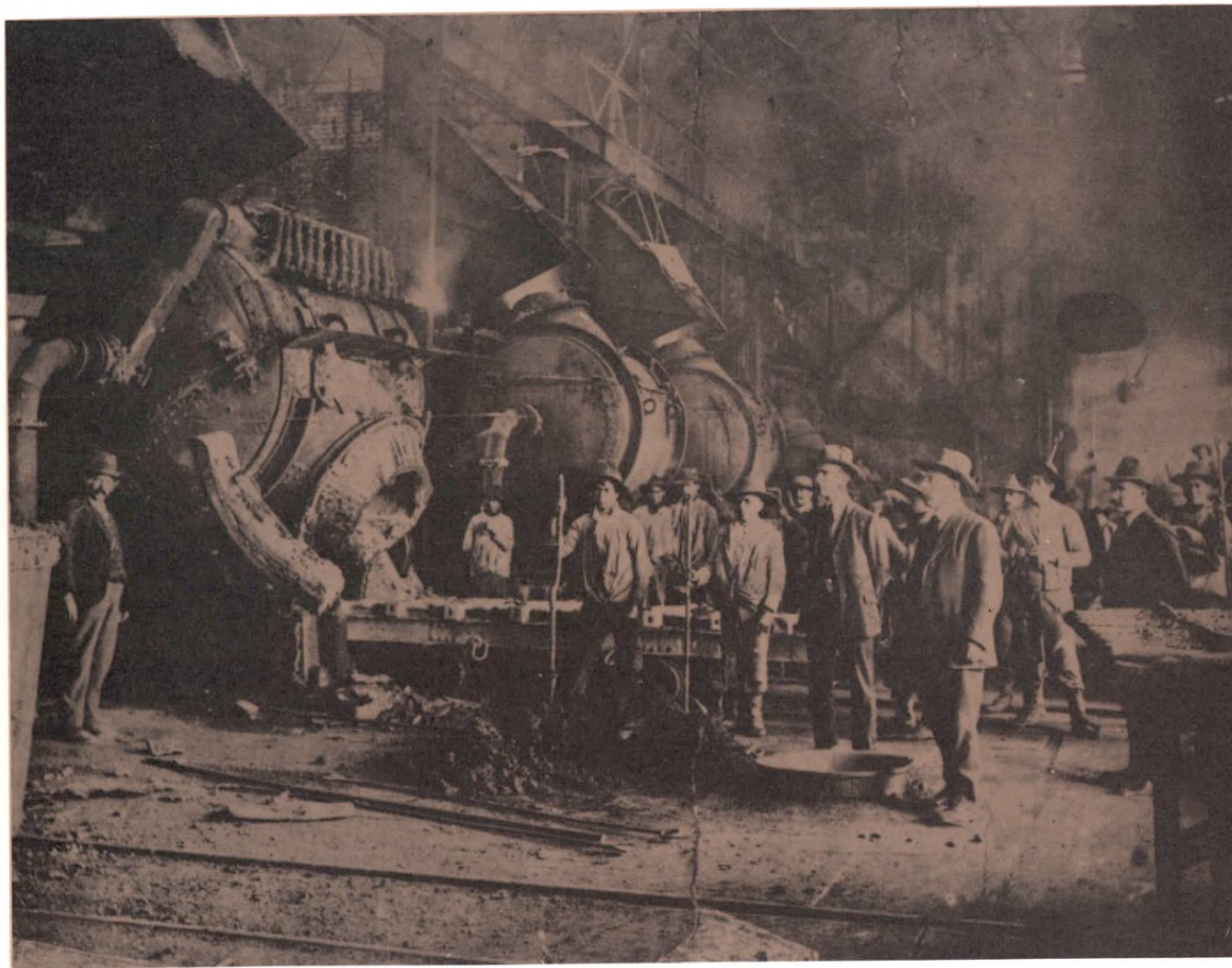
SALA DE CONVERTIDORES, DE LA FUNDICION INGLESA EN RIOTINTO, FOTO DE 1910.
