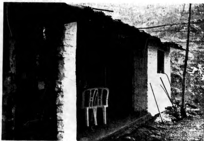
FIGURA 17. Construcción tipo C y D en la zona de influencia de la Cantera El Chocho.
