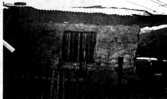
FIGURA 22. Construcción tipo C y D en la zona de influencia de la Cantera El Diamante.
