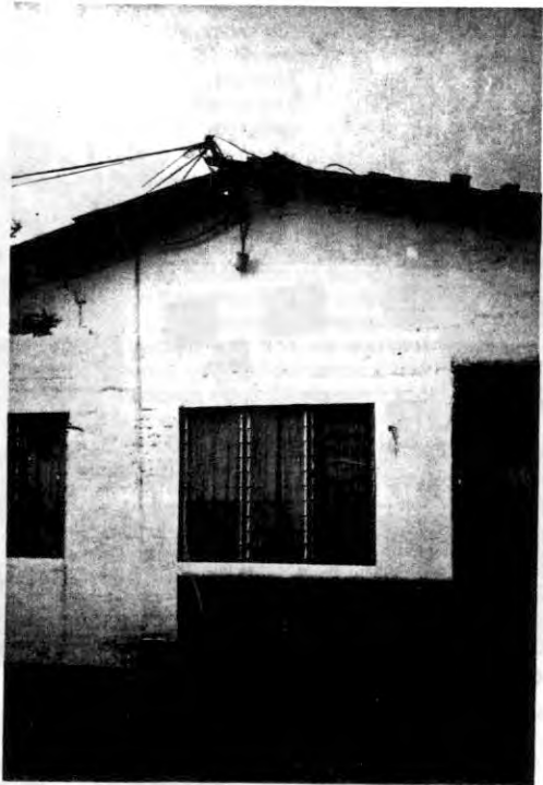
FIGURA 32. Estado actual de las oficinas de la Trituradora Inducón, construcción tipo C y D.
