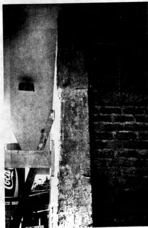
FIGURA 28. Construcción tipo B, en la zona de influencia de la Cantera Saratoga. Detalle de una columna anclada en roca fresca.
