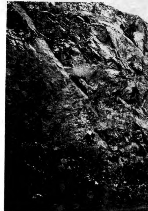
FIGURA 25. Detalle del grado de fracturamiento, diaclasamiento del macizo rocoso de la Cantera Saratoga.
