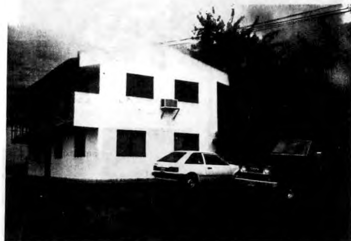
FIGURA 36. Construcción tipo A-B de las oficinas de la Trituradora Cachibi en buen estado.
