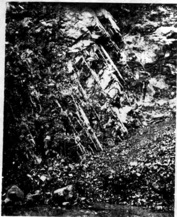
FIGURA 21. Detalle del grado de fracturamiento, diaclasamiento del macizo rocoso de la Cantera El Diamante
