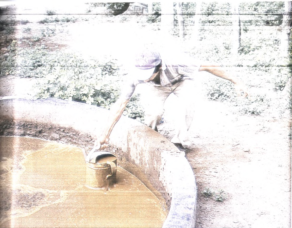
Efluente en el tanque de compensación
