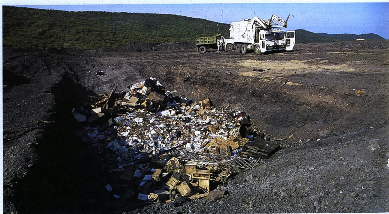
Relleno sanitario en el depósito de material estéril. Mensualmente se disponen alrededor de 750 toneladas de desechos en El Cerrejón - Zona Norte.
