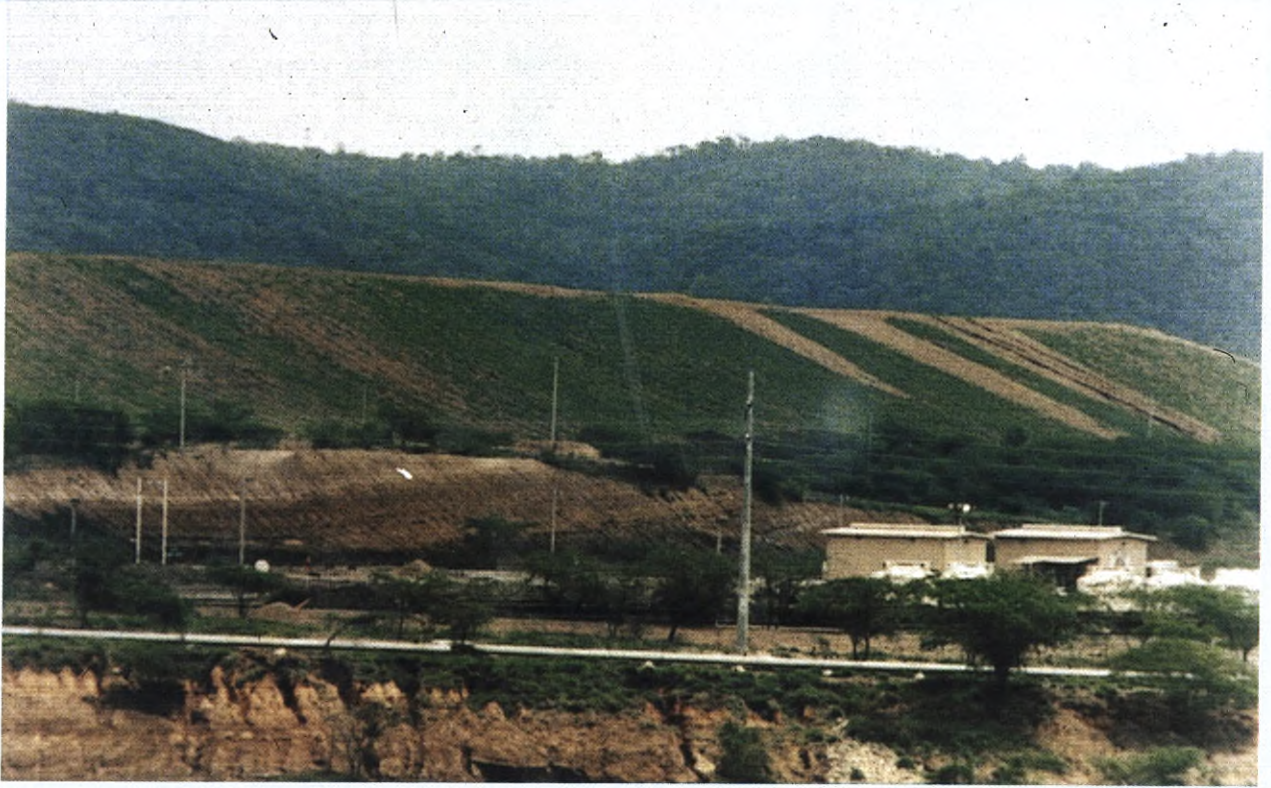
Revegetación de taludes en el área de depósito de material estéril.
