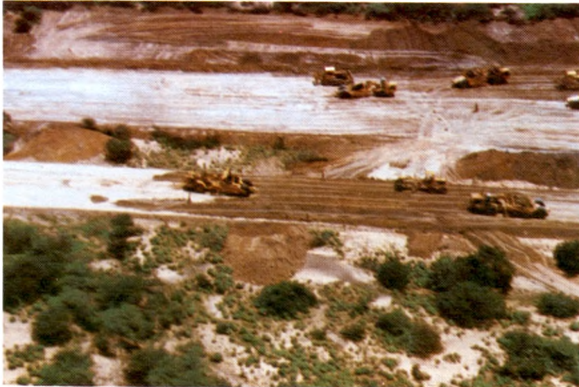
Obras civiles carretera Mina-Puerto.
