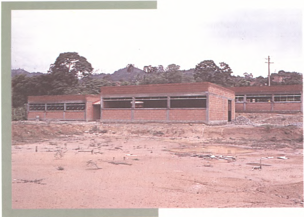
Ecocarbón construye Centro del Menor en Amagá - Antioquia
