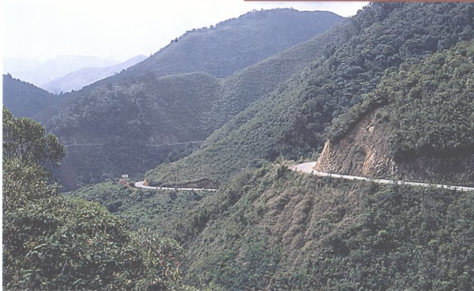
Carretera Angelópolis -Caldas, construida con aportes de Ecocarbón.
