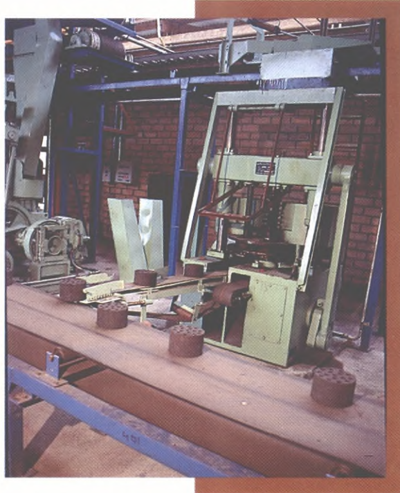
Fábrica Briquetas de Antioquia - Bricarbón
