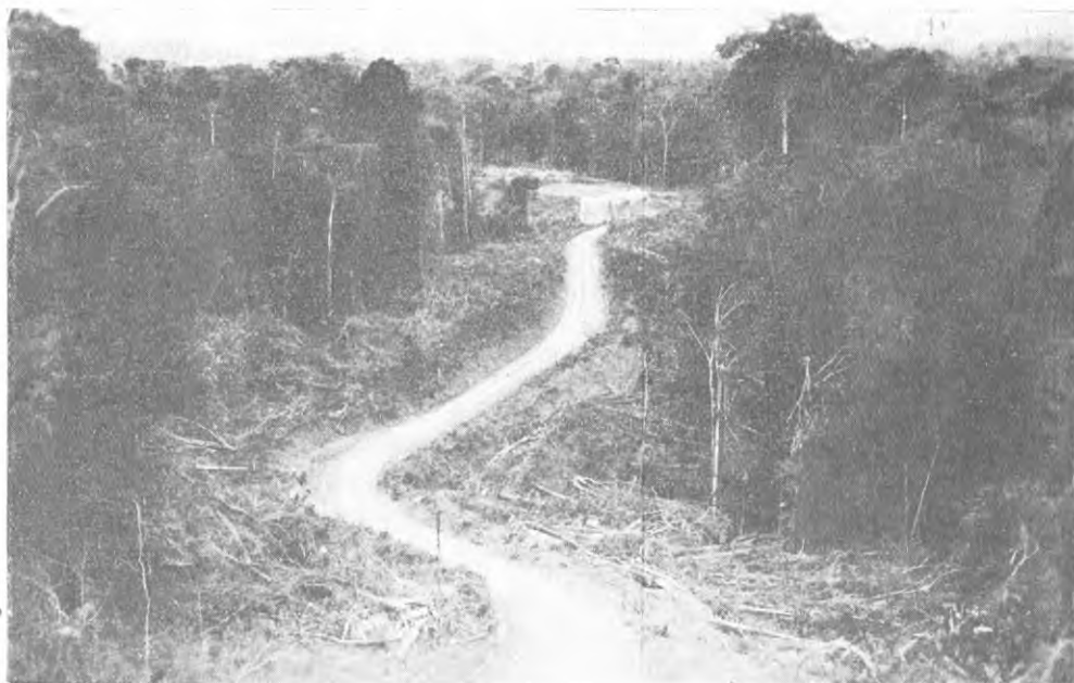
Fig. No. 14.—Carretera al Pozo No. 43, Colombian Petroleum Company, Campo de La Petrólea, Catatumbo.
