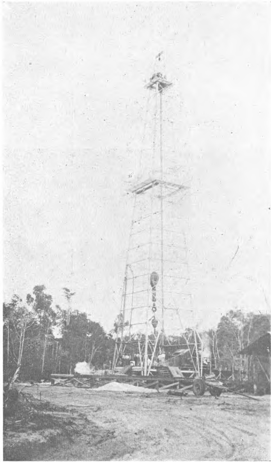
Fig. No. 18.—Pozo Peralonso N o 1. Torre de 136 pies de altura y equipo de perforación.—Socony-Vacuum Oil Company de Colombia. Concesión Restrepo.
