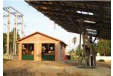
Foto. Vista casa de máquinas, base seguidor solar y tanques de combustible. 2011. Fuente. IPSE.
