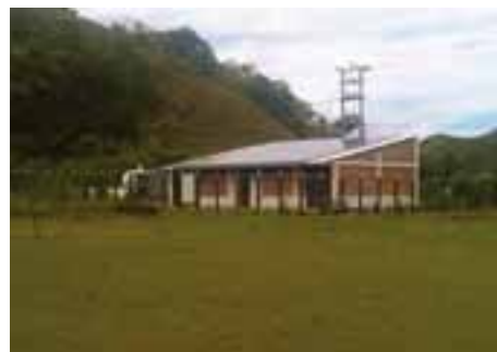
Foto. Vista Central de generación Solar-Diesel, municipio de Unguía - Chocó. 2009 IPSE
