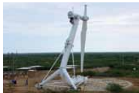
Foto. Vista aerogenerador. Nazareth-Guajira. 2011 IPSE
