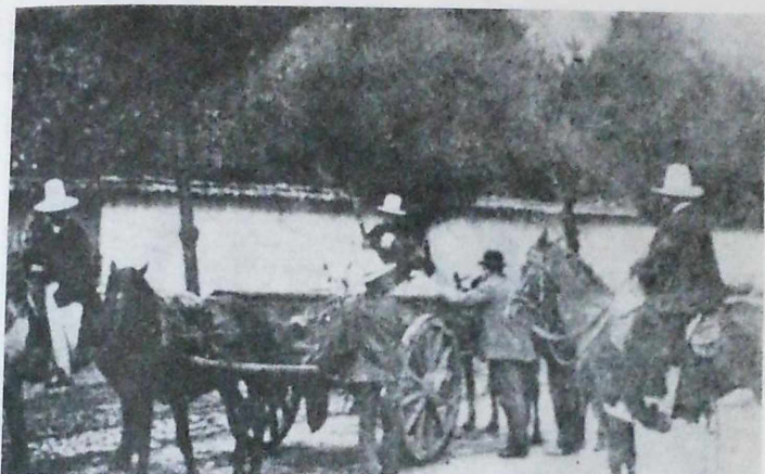
Traslado de materiales para la planta de El Charquito.
