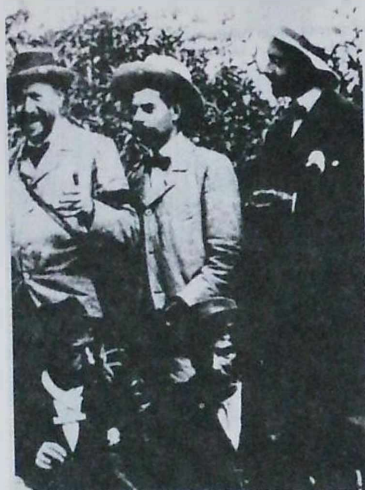
Don Santiago Samper Brush y sus colaboradores hacen una pausa durante la instalación de la planta de El Charquito.
