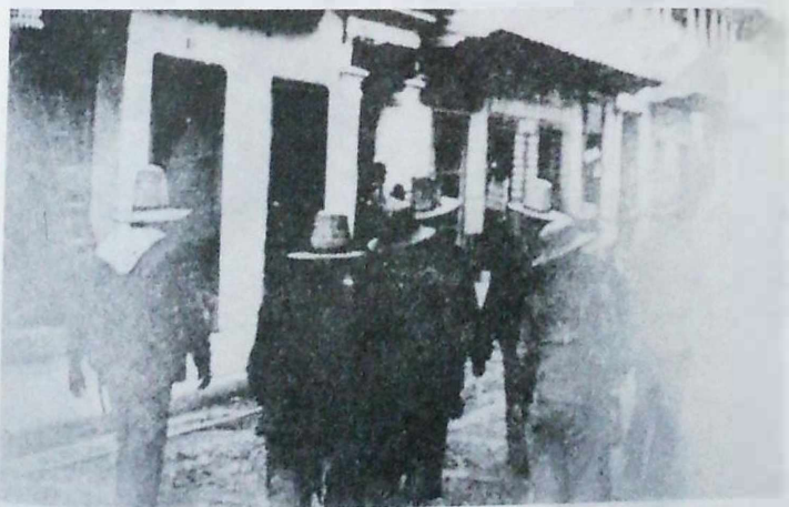
Los obreros de la Energía regresan a Bogotá después de haber concluido los trabajos de instalación de la planta de El Charquito. Faltan pocos días para la inauguración de la luz eléctrica en su segunda y definitiva etapa.
