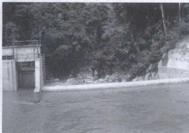
Proyecto Guarinó. Captación. Fuente: ISAGEN.
