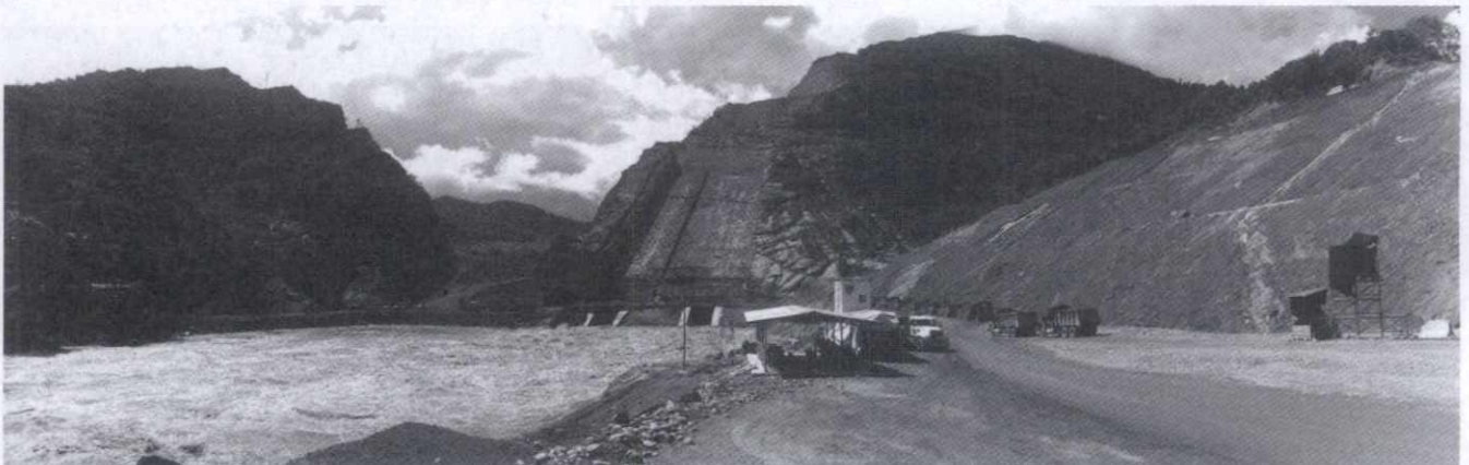
Proyecto Sogamoso. Panorámica de la construcción de la presa y el vertedero. Fuente: ISAGEN.
