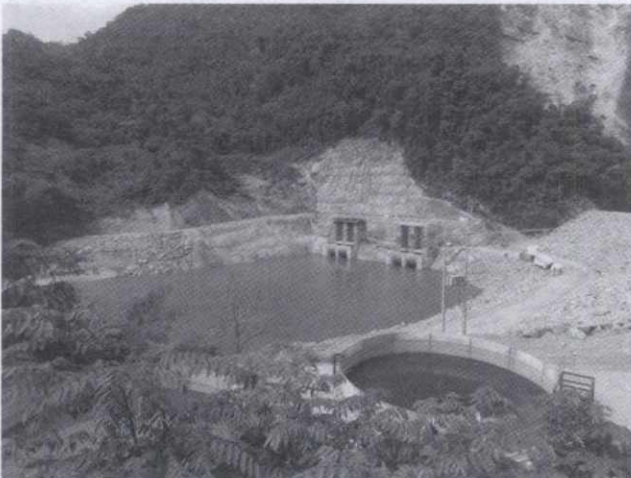
Proyecto Sogamoso. Aspecto del río entrando por los portales de entrada de los túneles de desvío. Sobre la derecha se aprecia el enrocado de la preatagüa. Fuente: ISAGEN.
