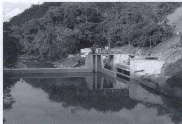
Proyecto Manso. Captación
