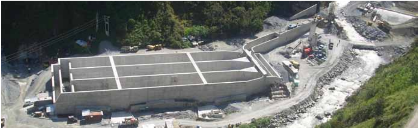
Proyecto Amoyá. Panorámica Captación. Fuente: ISAGEN.
