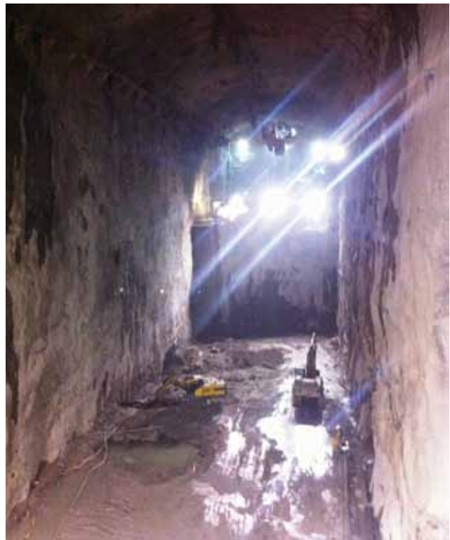
Proyecto Sogamoso. Avance en la excavación de la caverna de máquinas. Fuente: ISAGEN.
