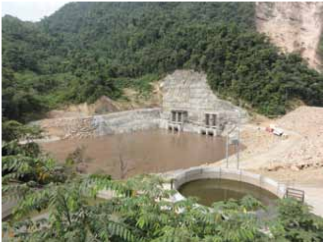
Proyecto Sogamoso. Aspecto del río entrando por los portales de entrada de los túneles de desvío. Sobre la derecha se aprecia el enrocado de la pretaigua. Fuente: ISAGEN.
