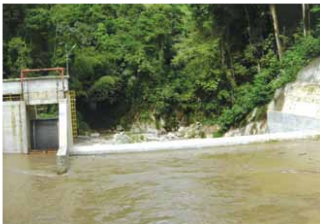
Proyecto Guarinó. Captación. Fuente: ISAGEN.
