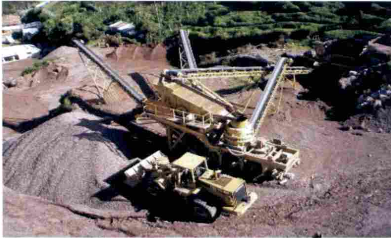
Montaje para producir gravilla
