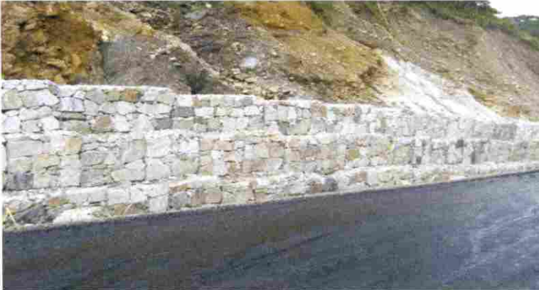
Pavimentación carretera del Cusiana
