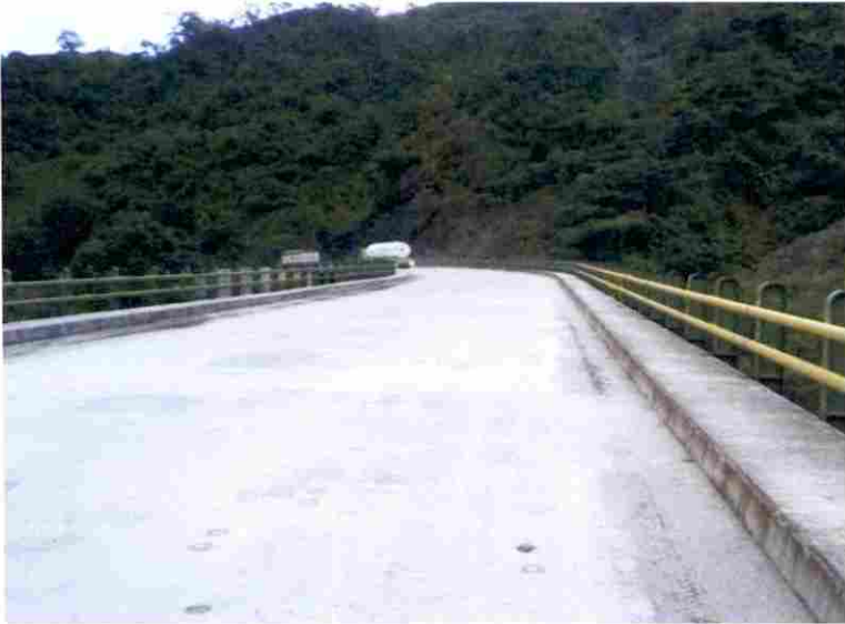
Viaducto carretera del Cusiana
