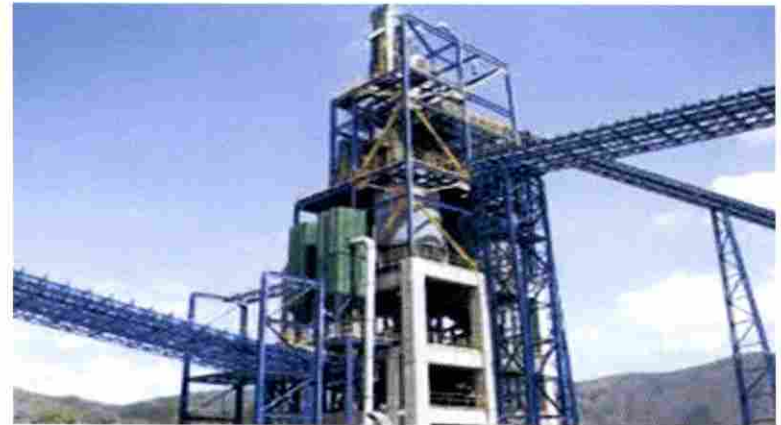
Fabricación de cemento Fuente: Holcim Colombia S.A.
