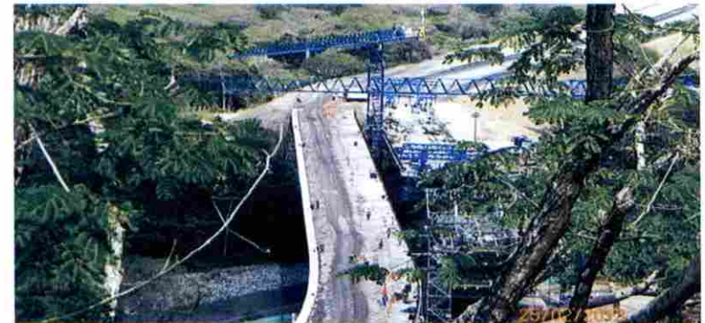
Construcción de puentes y obras de viales, Ruta del Sol, Colombia Fuente: INVIAS
