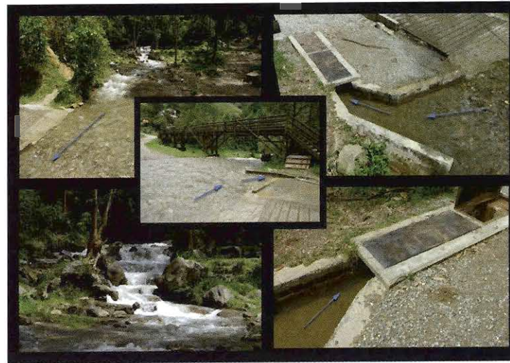
Figura 4-23. Obra de captación existente en el parque.
