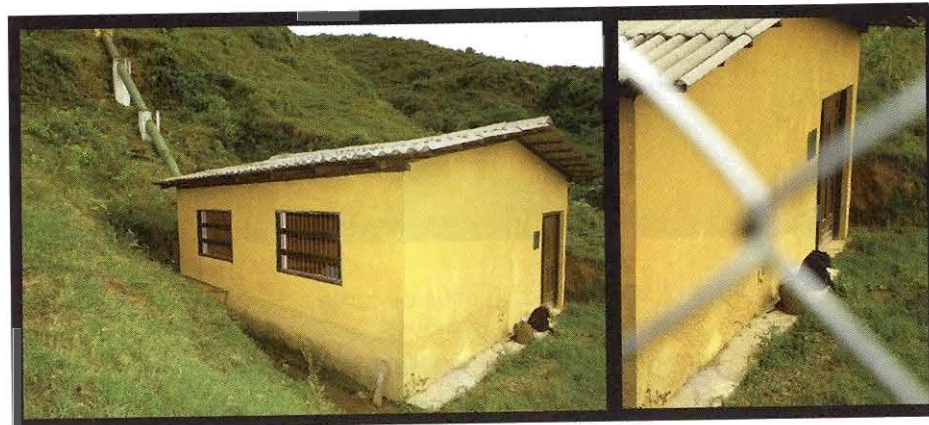
Figura 4-5. Casa de máquinas.
