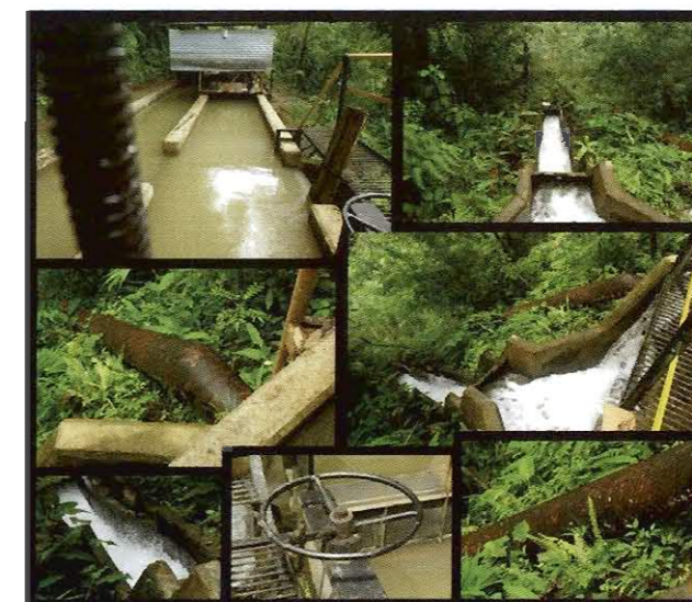
Figura 4-15. Tubería de presión y aliviadero.
