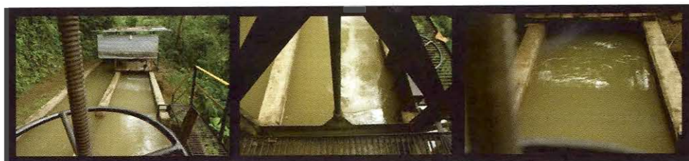
Figura 4-13. Desarenador y tanque de carga
