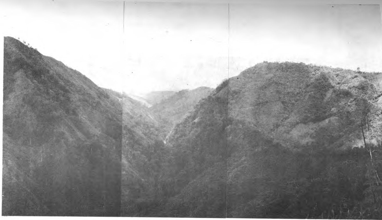
SITIO DE PRESA VISTO HACIA AGUAS ABAJO
