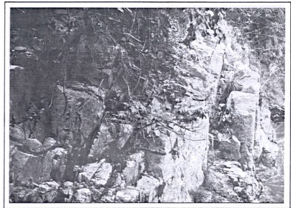
FOTO 14. — Tomada de NW - Se muestra diaclasamiento de rumbo 234/86 en neises del Macizo de La Plata. Márgen derecha del río Pdez.
