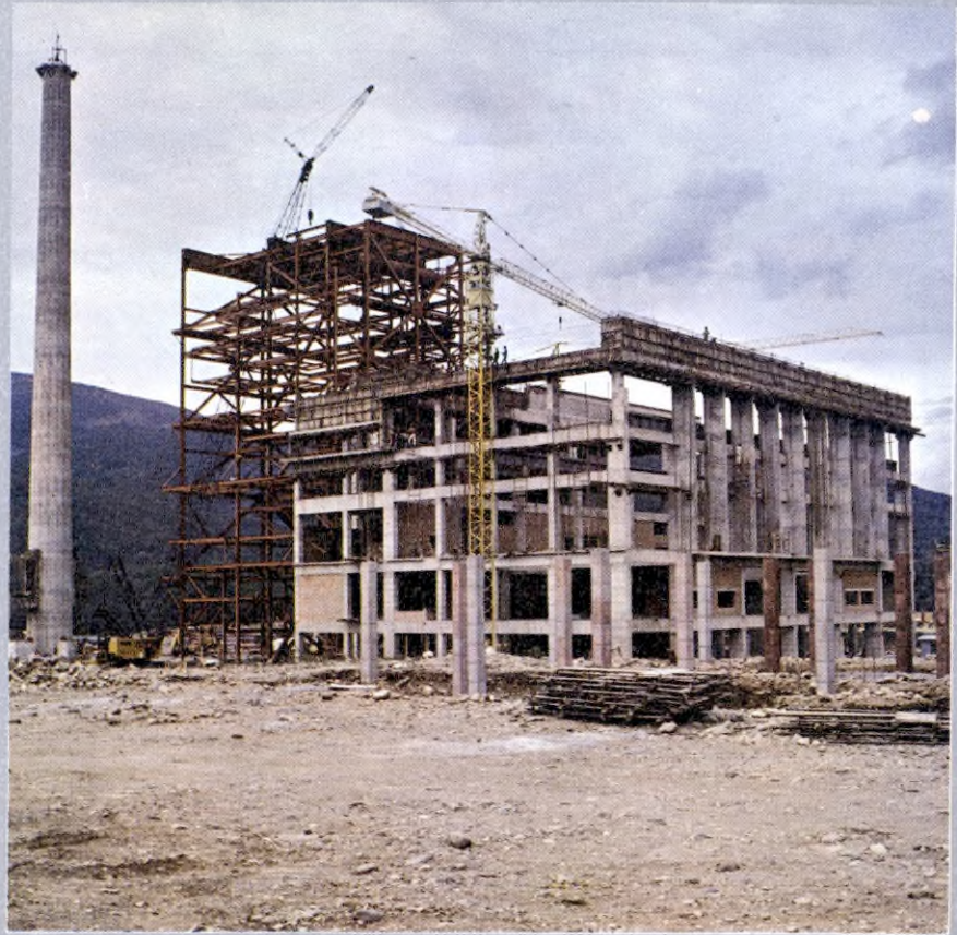
Construcción de la Central Térmica de Tasajero en el Departamento de Norte de Santander
