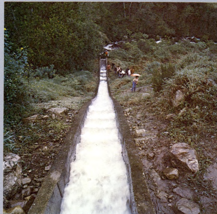
Canal de Conducción de agua en la Microcentral de Pisba
