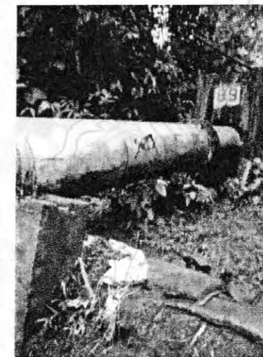
Foto No. 5 – Apoyo y Anclaje.
