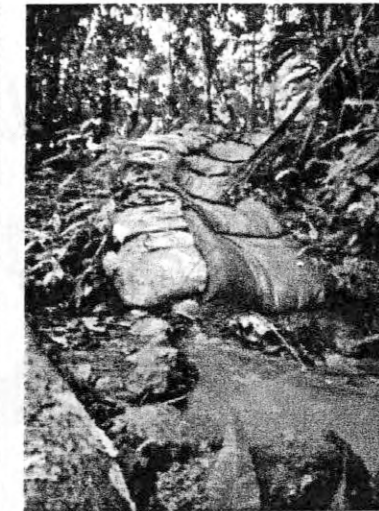
Canal de Protección
