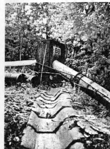
Foto No. 4 – Anclaje No. 88
