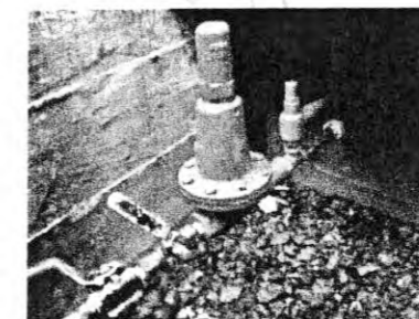
Reductor de presión de 560 psi a 40 psi
