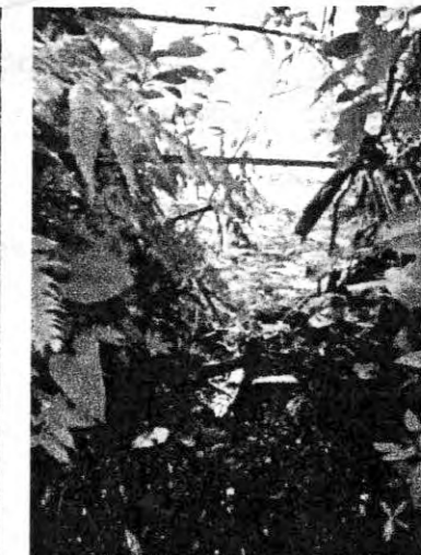
Obras Manejo de Agua
