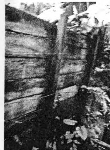
Trinchos, el cable que sostiene el trincho, se encuentra anclado en el apoyo de la tubería
