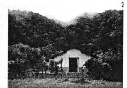
Exterior Casa de Máquinas
