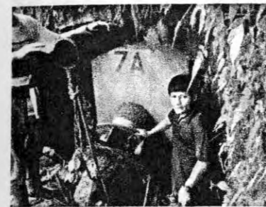
Apoyo 7A, Salida Túnel
