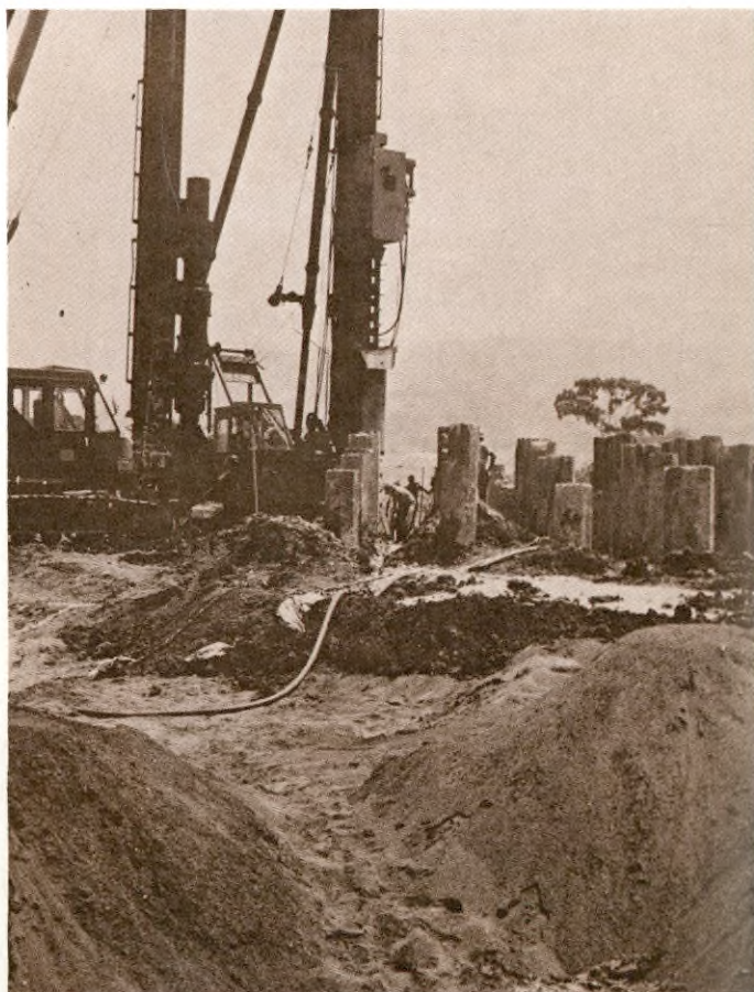
Labores de pilotaje en la construcción del horno para la planta procesadora de níquel de Cerromatoso S. A., en Montelíbano, Córdoba.
