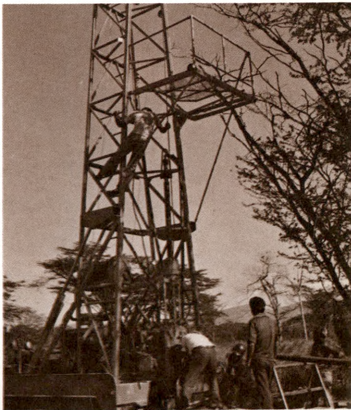
Equipo de perforación en la exploración del carbón. Proyecto Cerrejón, Guajira.
