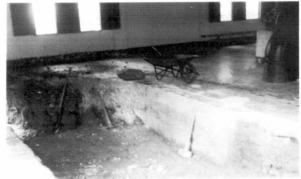
EXCAVACION CANAL DE DESCARGA Y CIMENTACION TURBINA KAPLAN
