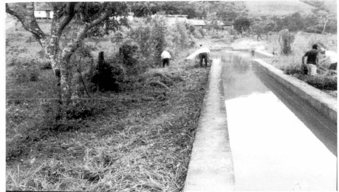
ESTRUCTURA DE DESARENADOR AMPLIADO EN PRIMERA ETAPA
