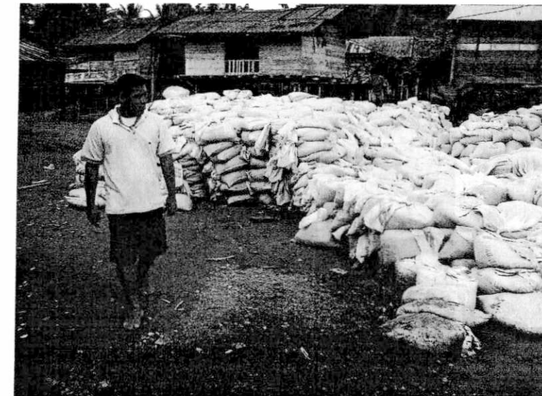
FOTOGRAFÍA No. 4. PCH BAHÍA SOLANO Acopio de material de río para transportar al sitio de las obras
