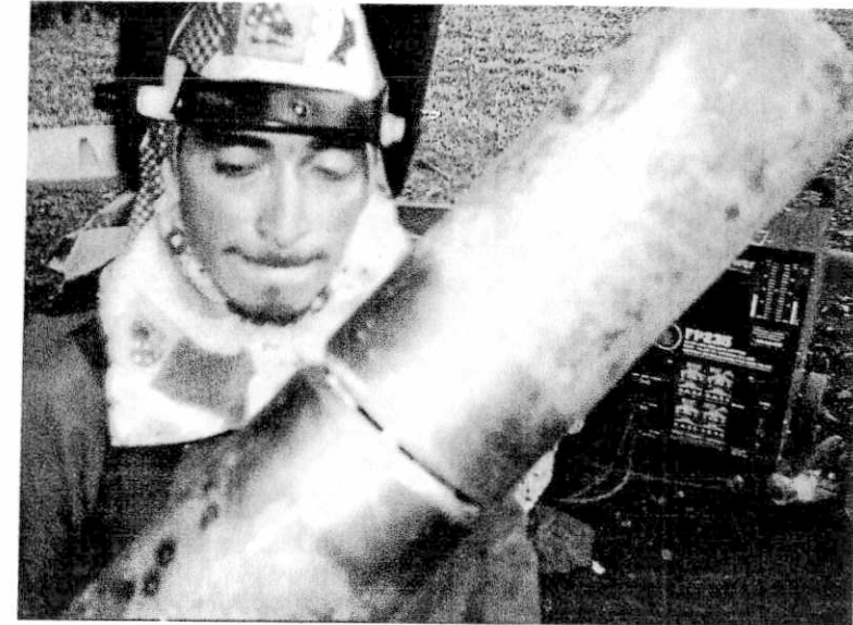
FOTOGRAFÍA No. 5. PCH BAHÍA SOLANO Pruebas de soldadura
