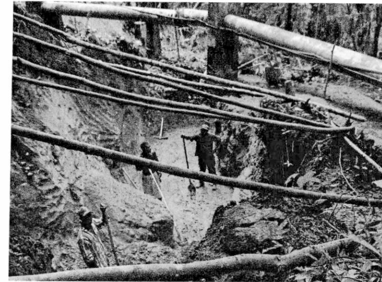
FOTOGRAFÍA No. 24. PCH BAHÍA SOLANO Excavación en cajón para el nuevo alineamiento de la tubería
