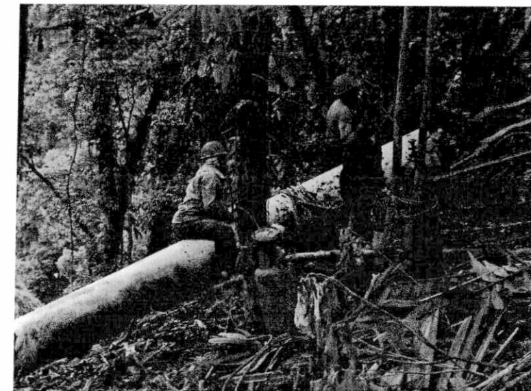
FOTOGRAFÍA No. 8. PCH BAHÍA SOLANO Traslado de la tubería existente hasta el sitio de las obras
