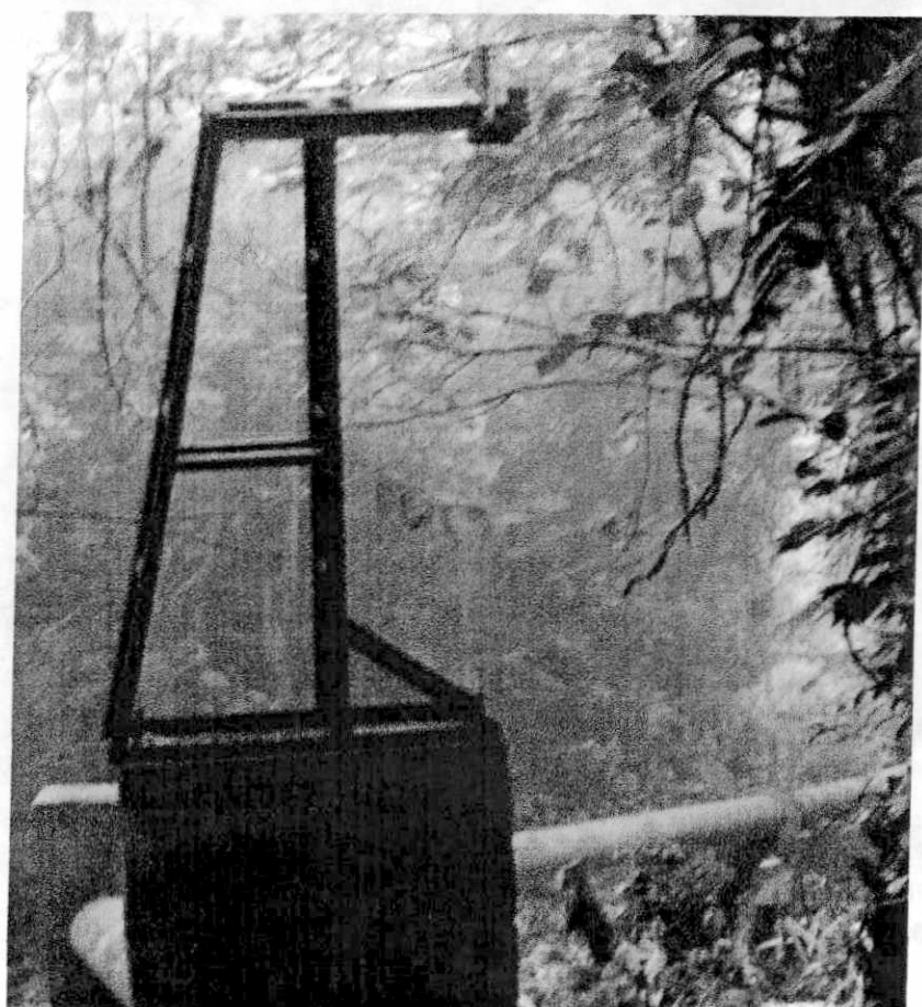
Montaje de torres de teleférico en Apoyos de concreto
