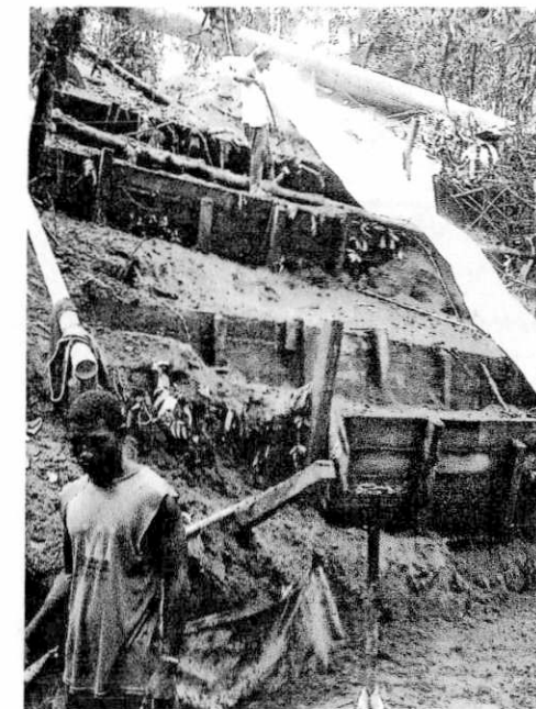
FOTOGRAFÍA No. 17. PCH BAHÍA SOLANO Conformación y adecuación de trinchos
