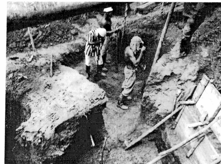
FOTOGRAFÍA No. 20. PCH BAHÍA SOLANO Trabajos de excavación – personal de la zona
