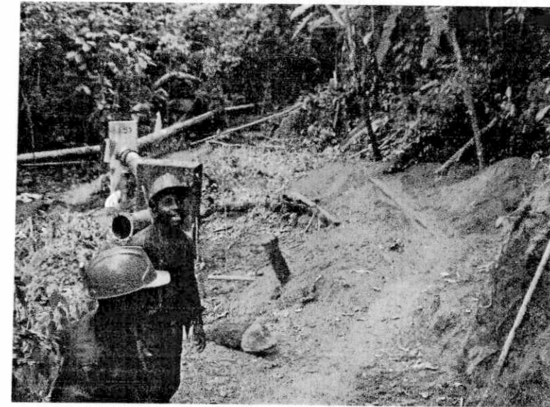
FOTOGRAFÍA No. 14. PCH BAHÍA SOLANO Sitio de los trabajos en la corona del talud
