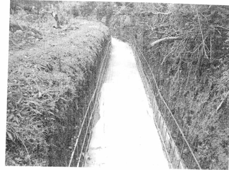
FOTOGRAFÍA No. 30. PCH EL BUCO Desarrollo de las obras civiles – canal (fuera del alcance del presente convenio)
