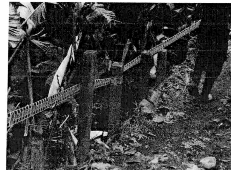
FOTOGRAFÍA No. 26. PCH BAHÍA SOLANO Conformación de llenos y barreras para adecuación del camino de acceso al sitio de las obras
