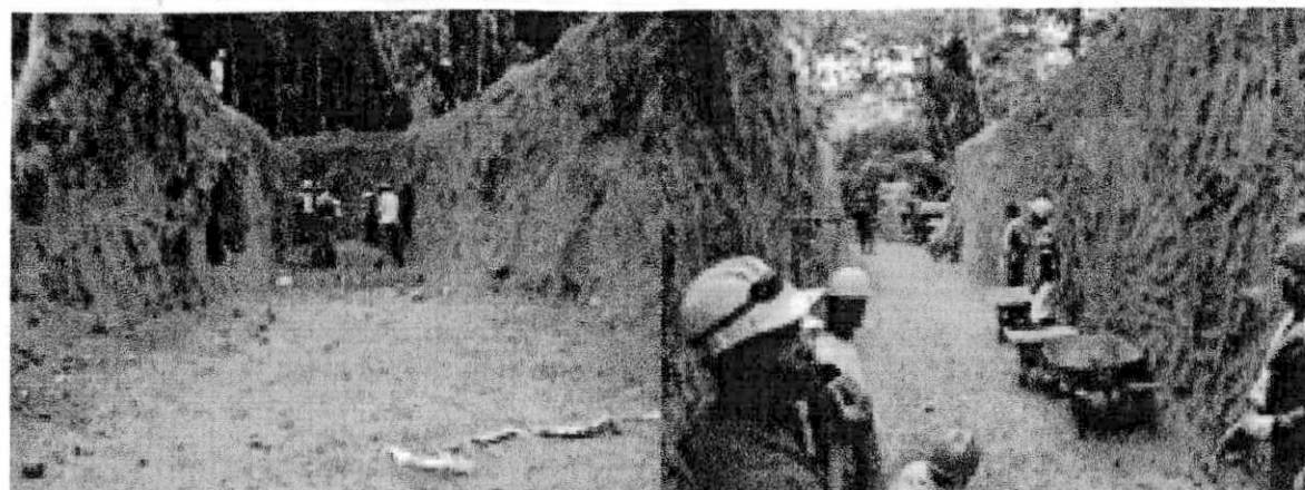
Excavación a nivel inferior de tubería.
