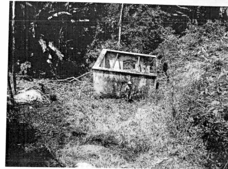
FOTOGRAFÍA No. 29. GABYPOL - ARARACUARA ESTADO ACTUAL DE LA CASA DE MAQUINAS A REMODELAR
