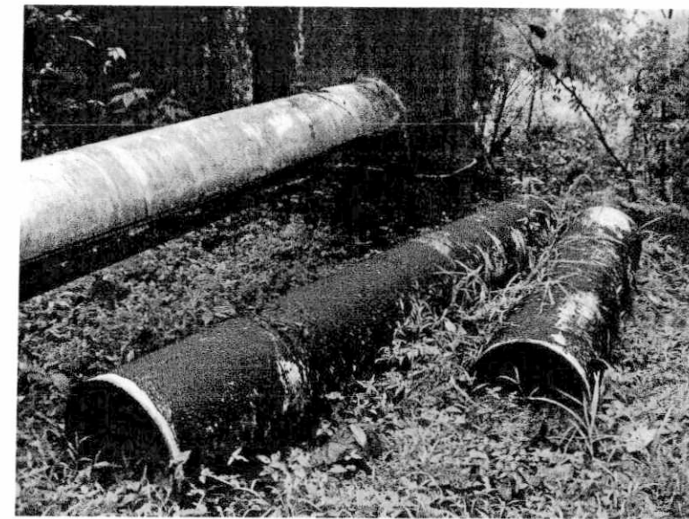
FOTOGRAFÍA No. 7. PCH BAHÍA SOLANO Tubería existente
