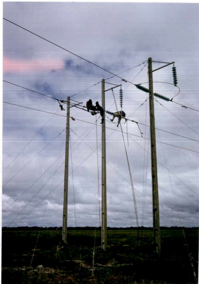
TENSIONADO Y AMARRE DE CONDUCTORES
