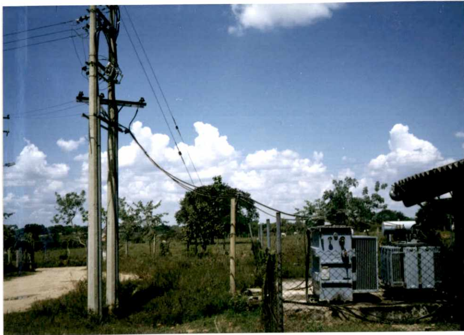
BANCO DE TRANSFORMADORES EN SERIE EN LA S/E. ACTUAL DE PUERTO LOPEZ.
