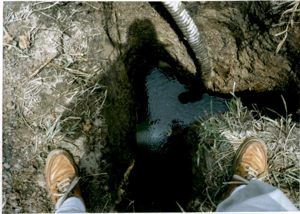
EXCAVACION PARA ANCLAJES DE TEMPLETES ( OBSERVESE EL NIVEL FREATICO )
