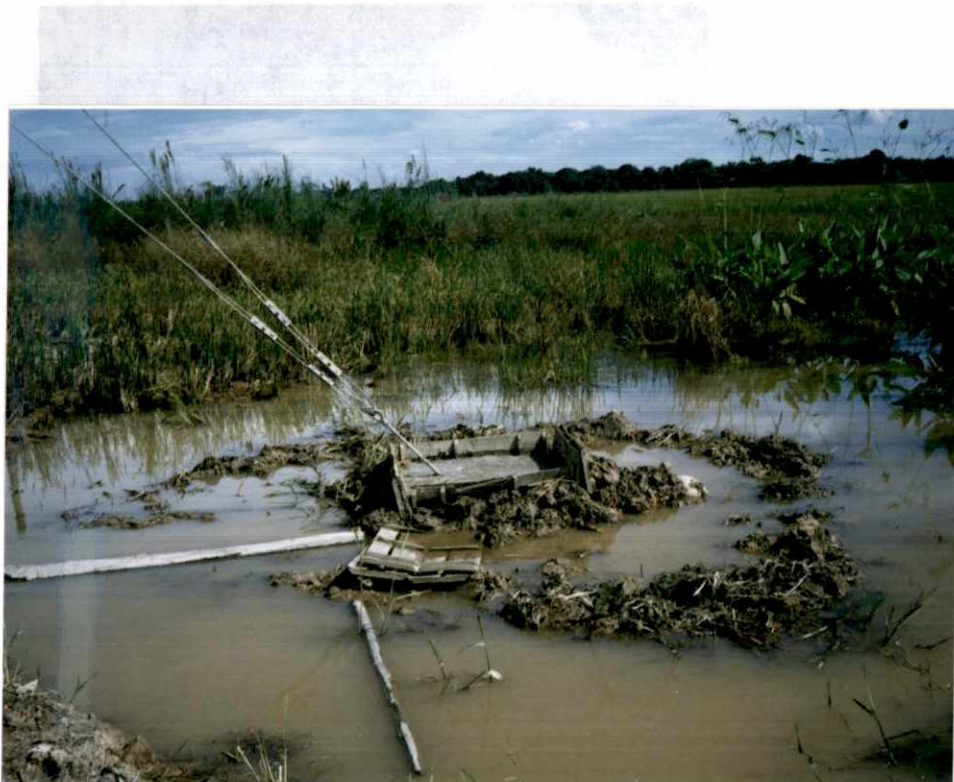
ANCLAJE DE TEMPLETE FUNDIDO EN CONCRETO DE 2500 PSI.
