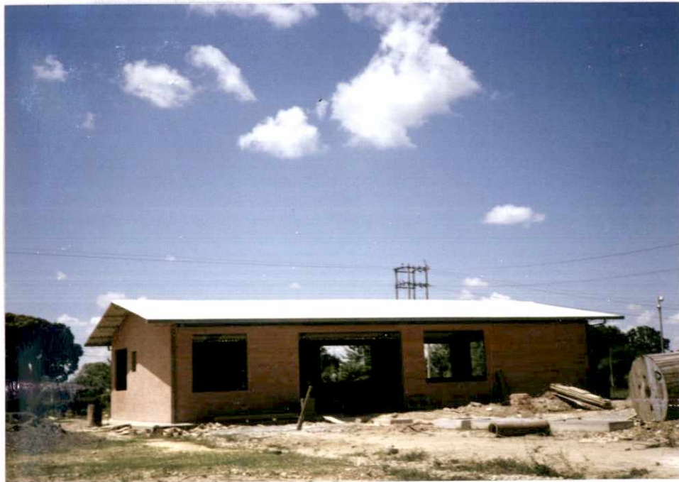
ESTADO ACTUAL DE LA CASETA DE CONTROL PARA LA NUEVA SUBESTACION EN PUERTO LOPEZ.
