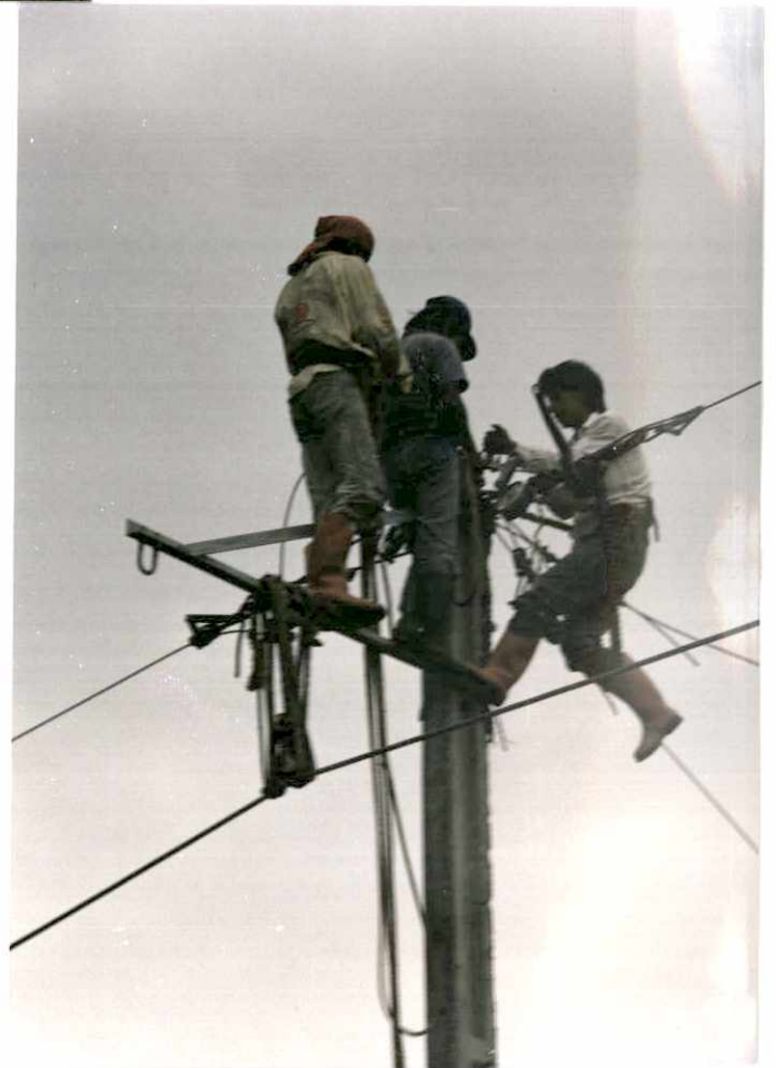
TENSIONADO DE CABLE DE GUARDIA
