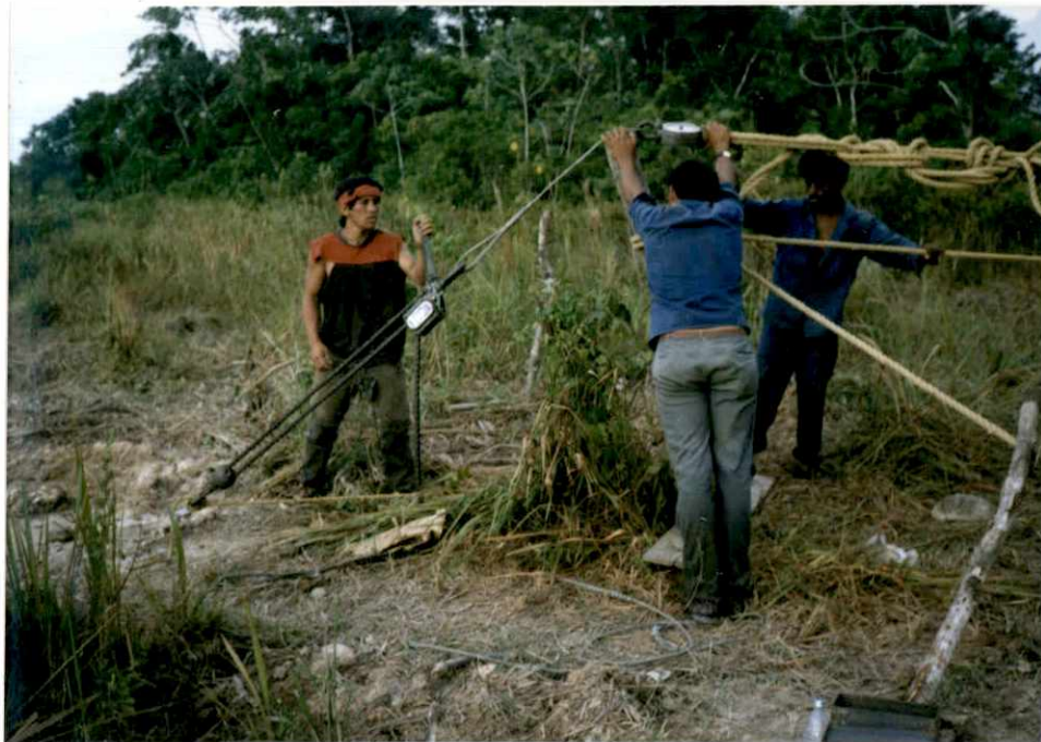
PRUEBA A TENSION DE UN ANCLAJE FUNDIDO EN TERRENO FANGOSO
