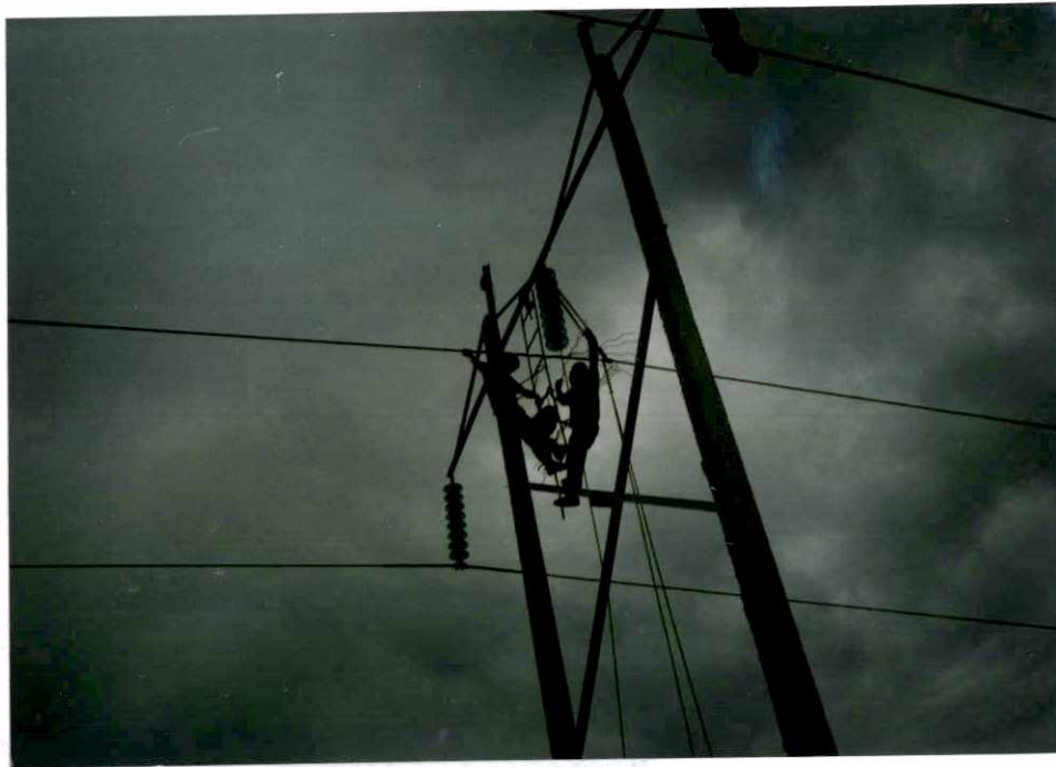
INSTALACION DE BLINDAJES DEL CONDUCTOR EN ESTRUCTURA TIPO "S"
