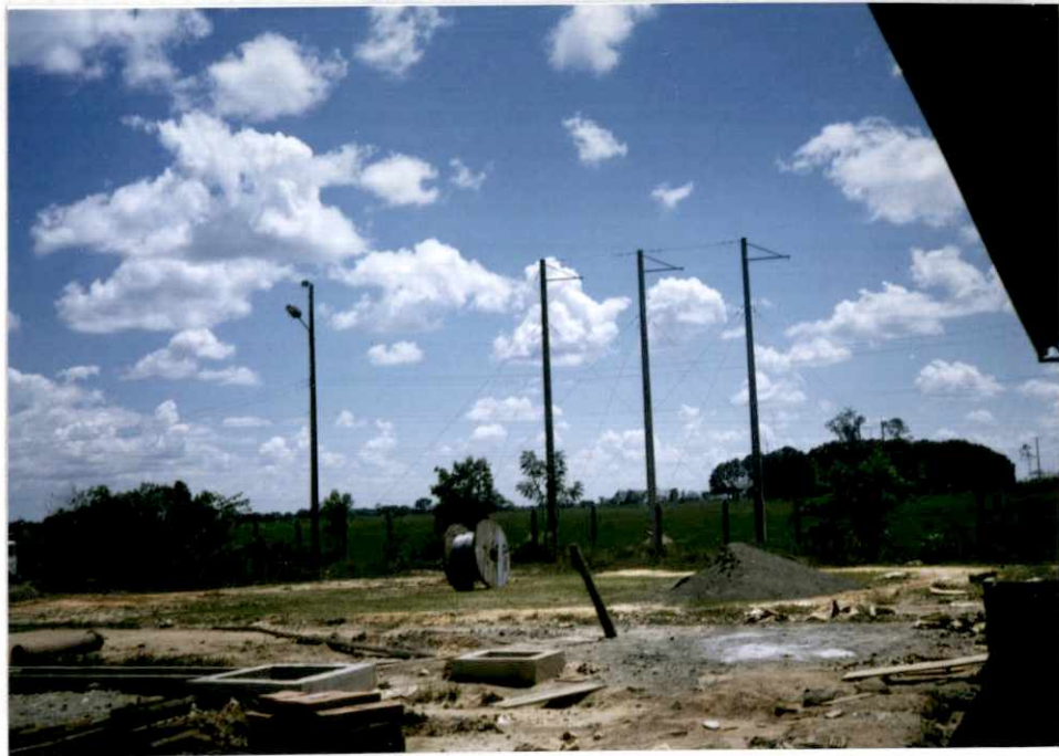
ESTRUCTURA DE LLEGADA DE LA LINEA A LA SUBESTACION DE PUERTO-LOPEZ Y VISTA GENERAL DEL PATIO DE ESTA S/E.
