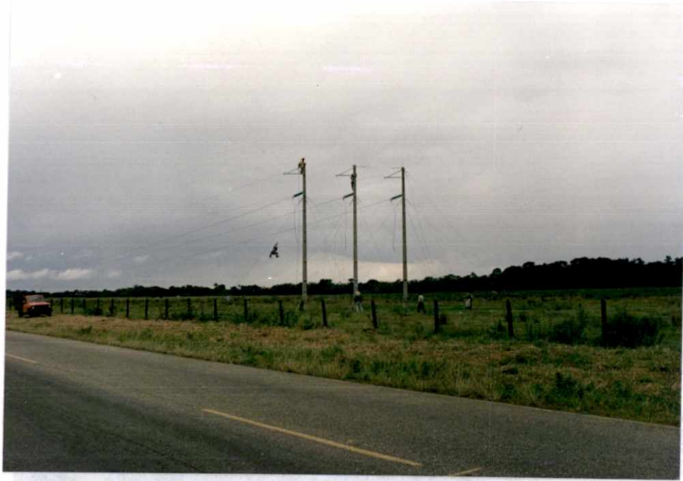
INSTALACION DE BLINDAJES DEL CONDUCTOR EN ESTRUCTURA
