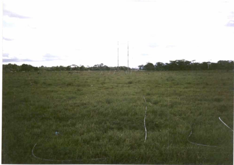
ESTACION DE TENDIDO DE CONDUCTOR
