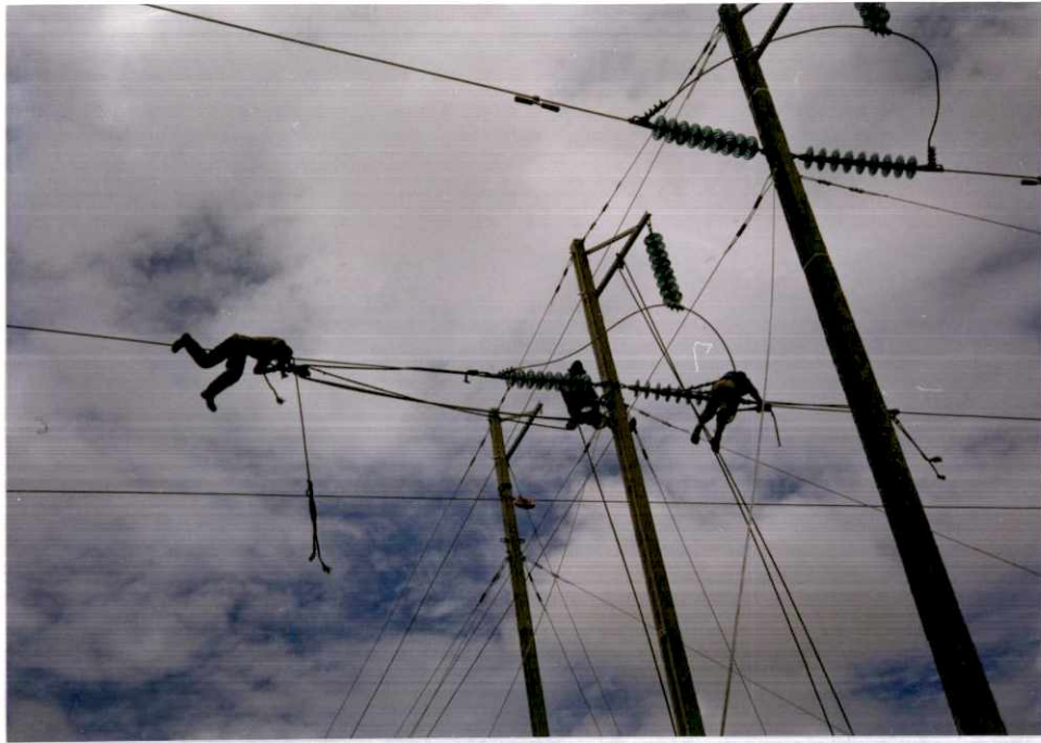
TENSIONADO Y AMARRE DE CONDUCTORES
