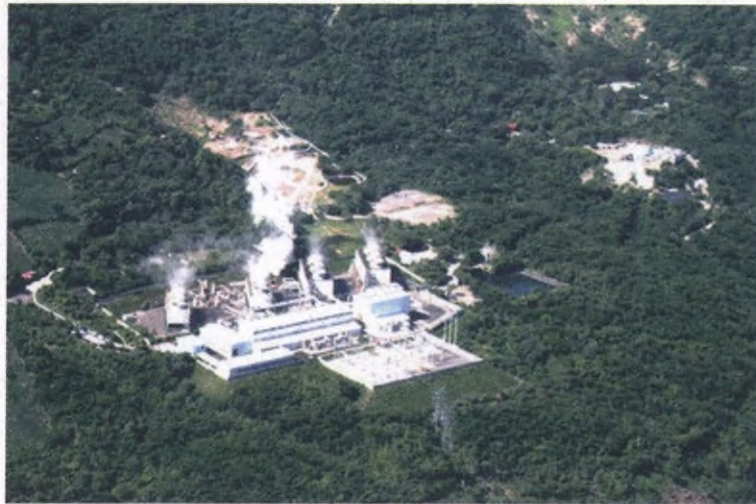
Planta y campo geotérmico Berlín El Salvador. (109 MW) 33 .
