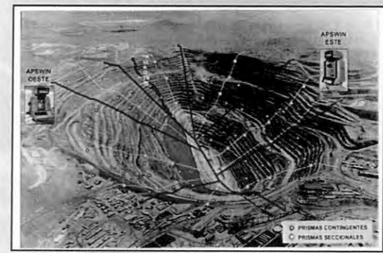
SISTEMA ROBÓTICO DE AUSCULTACIÓN DE DESPLAZAMIENTOS DE LOS TALUDES APSWIN.
