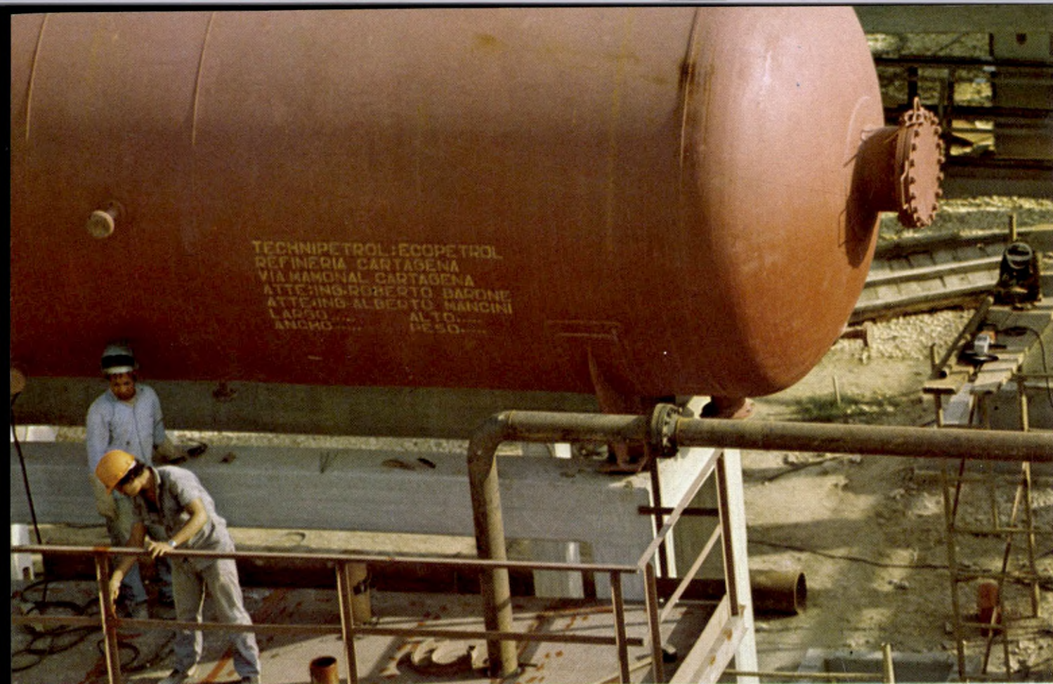
Instalación de tambores en la Refinería de Cartagena
