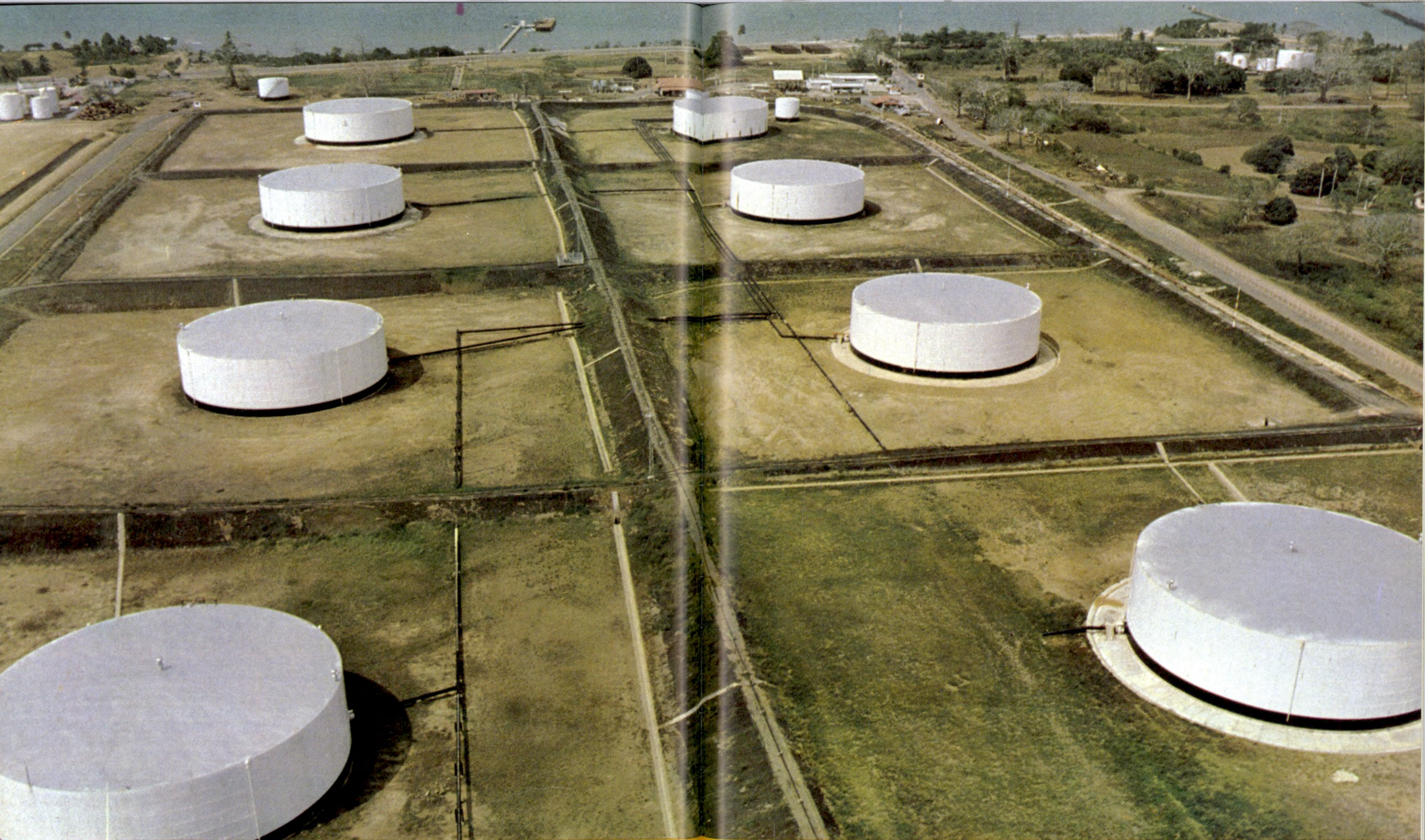
Tanques de almacenamiento en el Distrito de Cartagena
