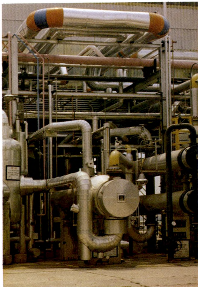
Intercambio de calor. Complejo Industrial de Barrancabermeja. Planta de Etileno ensamble de los equipos con tubería— CIB.
