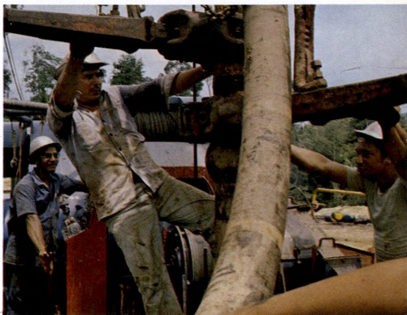
Aspectos de la perforación en Lisama, El Centro
