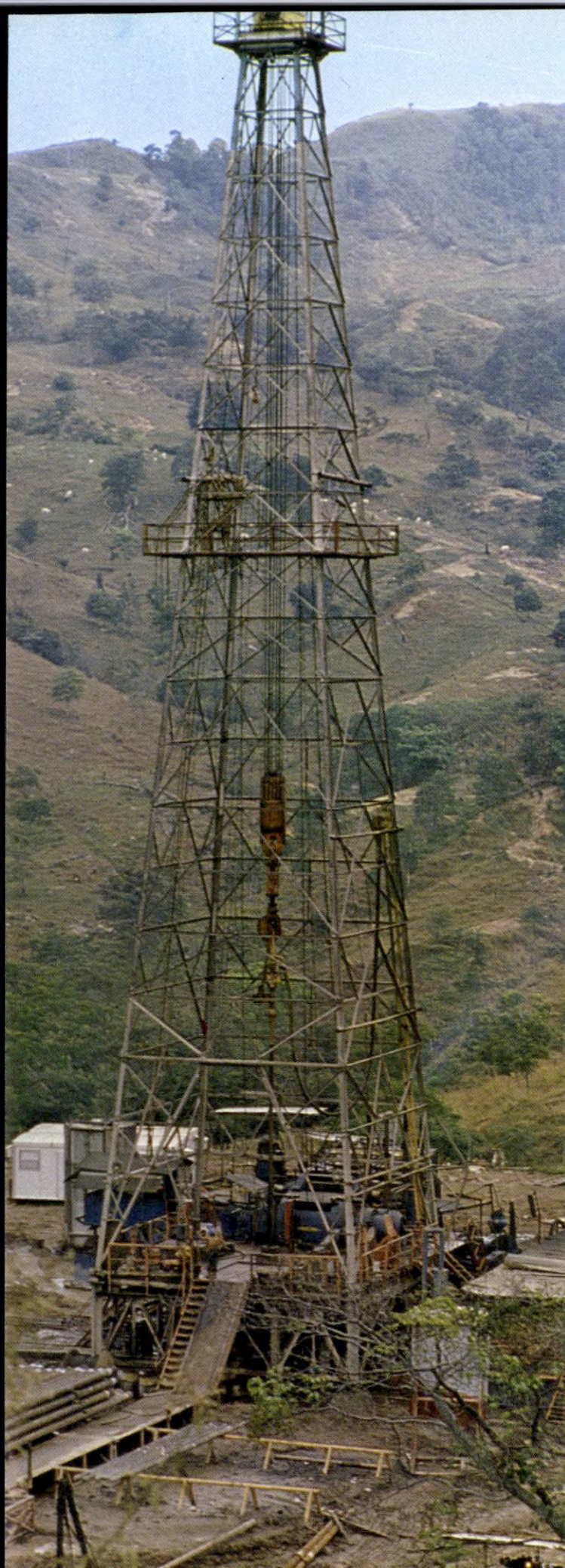
Pozo Santa Helena No. 1 (en perforación) Equipo Nacional 130
