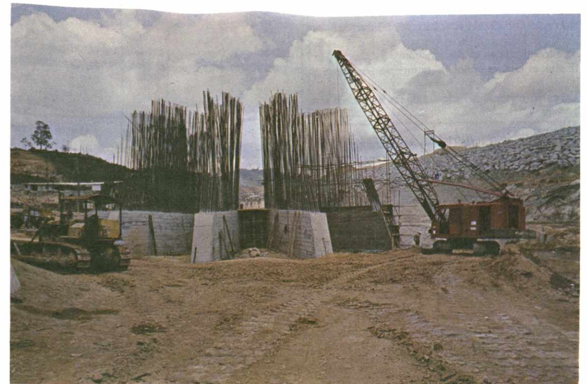
Vista de las obras de captación de la Central Hidroeléctrica de San Carlos. Capacidad primera etapa 620.000 kilovatios. (Fotografía ISA).
