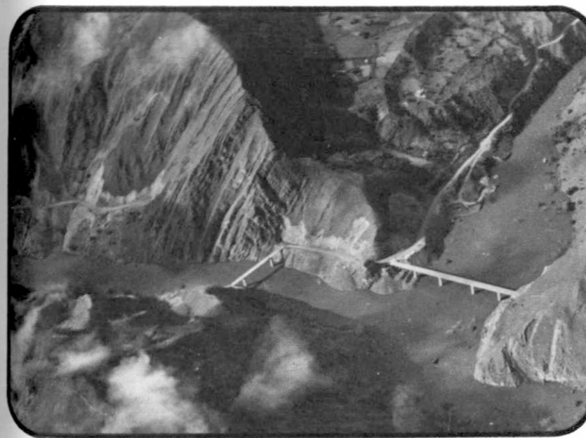
Central Hidroeléctrica de Chivor. Sistema vial
