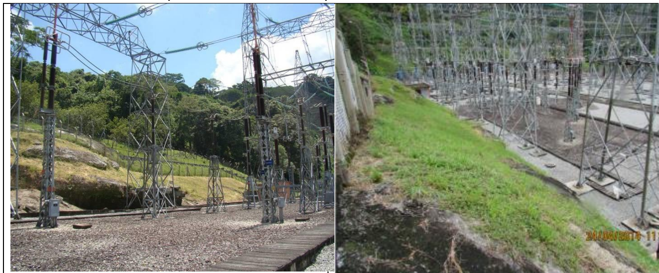
Gráfica 6-8 Espacio donde eventualmente se podría construir nueva bahía de línea de 500 kV
