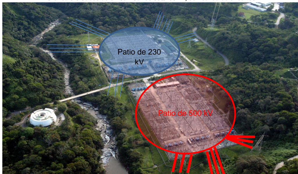
Gráfica 6-6 Subestación San Carlos 500/230 kV, con salida de circuitos
