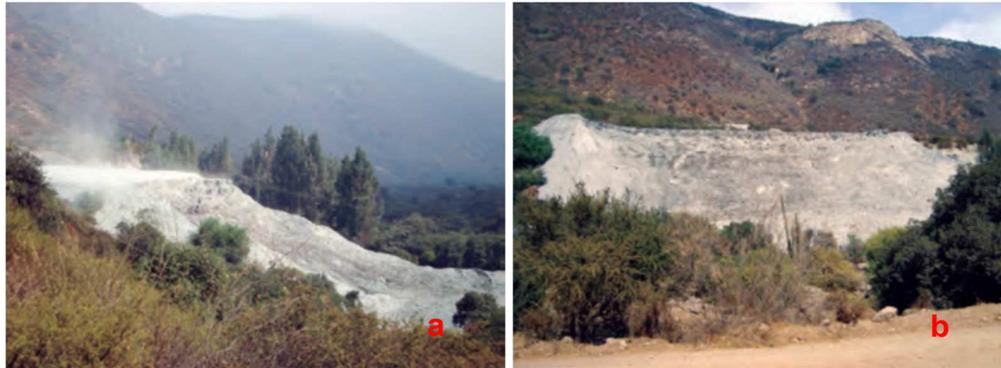
**Figura 9. Movimientos en masa por inestabilidad de talud presa de relaves en proceso de post cierre.**
