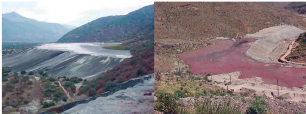
**Figura 13. Rebese de presa de relaves, estanque de decantación - aguas claras adosadas al muro resistente de presa de relaves.**
